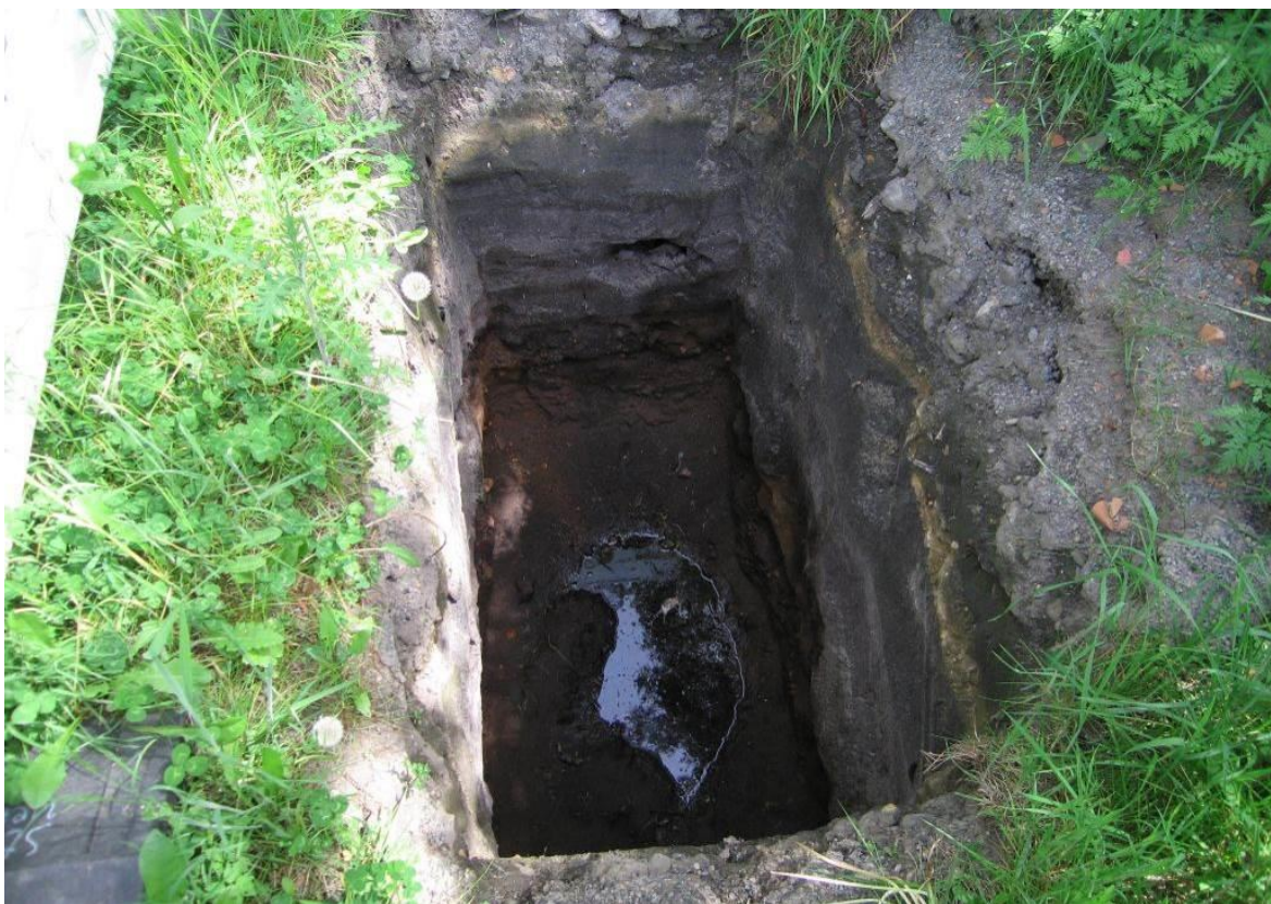
Abb. 31: ...ungesicherte Baugruben stellen eine Falle für verschiedene Tierarten dar – mehrere tote Mäuse sowie lebende Grasfrösche konnten in diesem Erdloch gefunden werden, das von den Stadtwerken Böhmetal (vgl. Abb. 30) ausgehoben wurde (GS, 22.05.2014).
