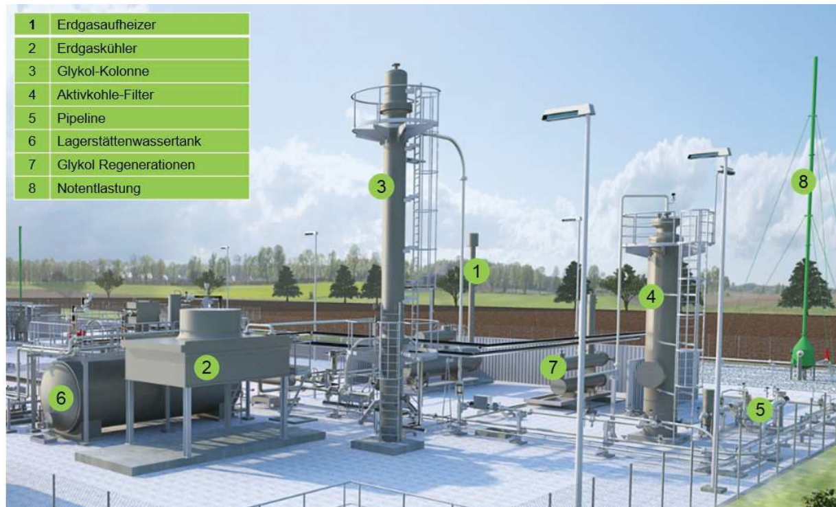
Abbildung 3: Übersicht Förderplatz Goldenstedt Z9 (Aufbereitungsanlage)
