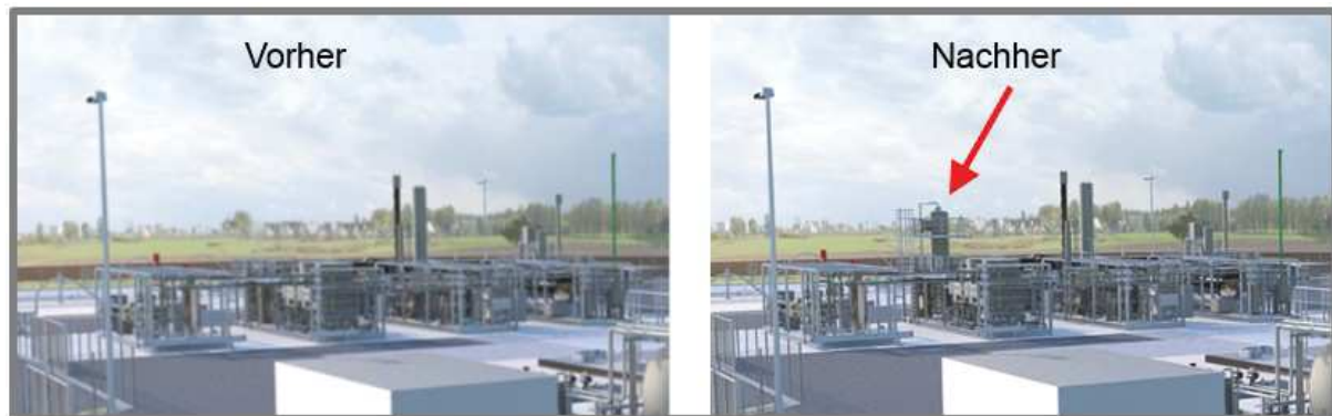
Abbildung 4: Übersicht Umbauarbeiten Goldenstedt Z23 (vorher - nachher)
