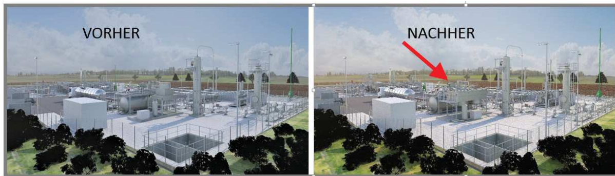
Abbildung 5: Übersicht Umbauarbeiten Goldenstedt Z9 (vorher - nachher)
