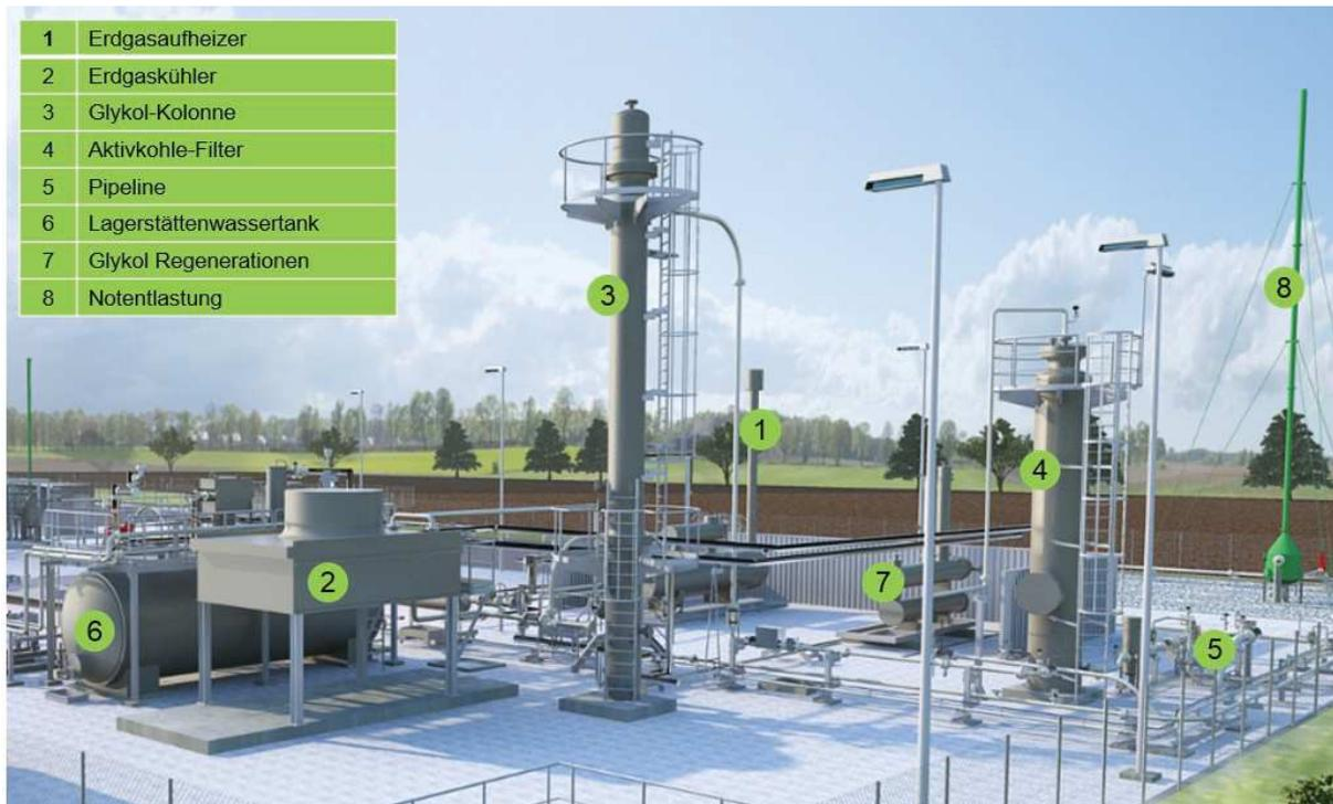
**Abbildung 4: Übersicht Förderplatz Goldenstedt Z9 (Aufbereitungsanlage)**
