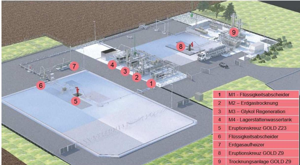
**Abbildung 3: Übersicht technische Anlagen auf dem Förderplätze Goldenstedt Z23 und Z9**
