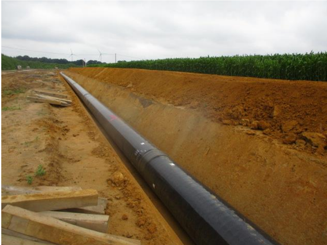
Abb. 3-12: In den Rohrgraben abgesenkter Rohrstrang, Quelle: uventus
