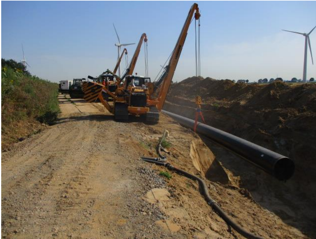
Abb. 3-11: Absenken des Rohrstrangs, Quelle: uventus
