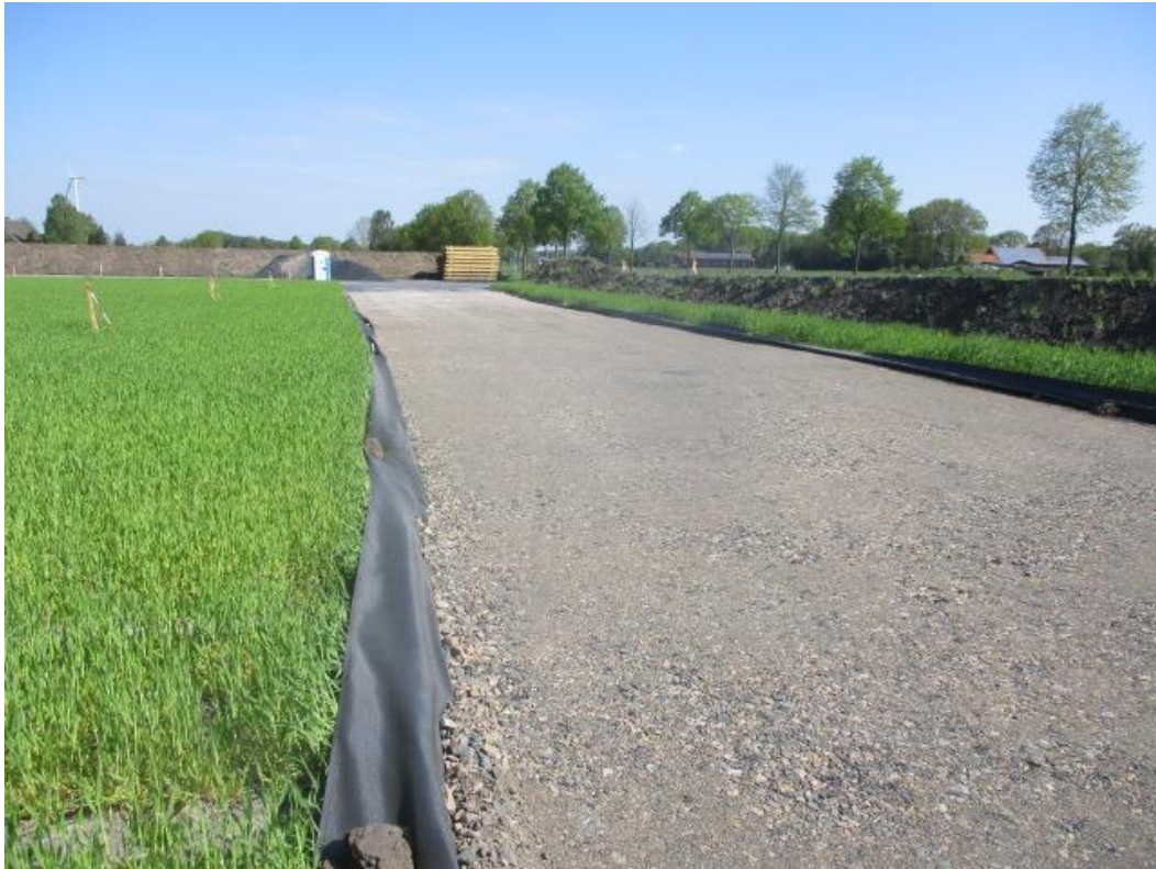
Abb. 3-7: Baustraße aus Schotter mit unterlegtem Vlies, Quelle: uventus
