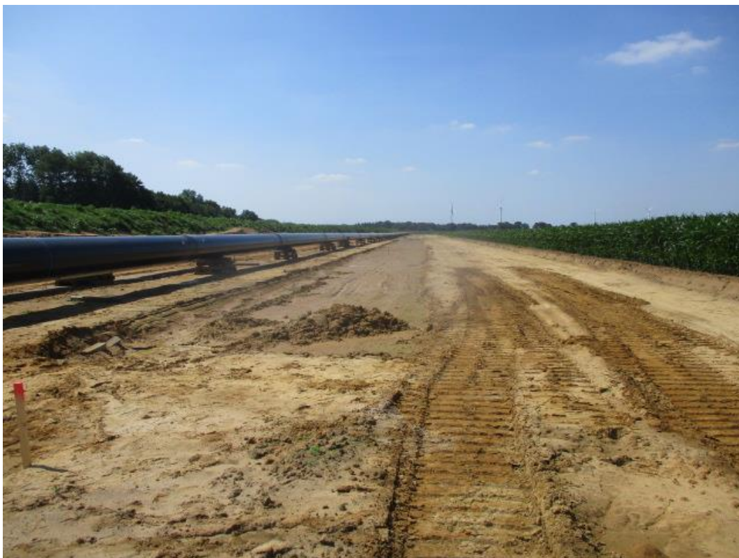
Abb. 3-10: Vormontierter Leitungsstrang, Quelle: uventus
