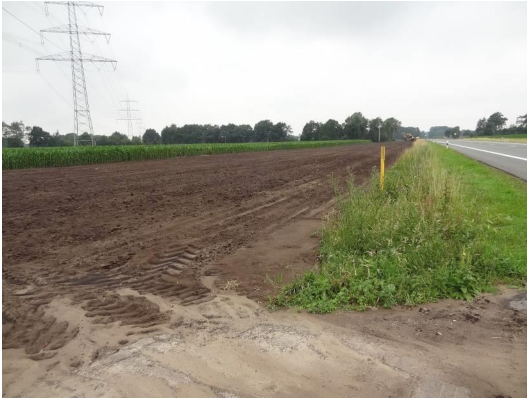
Abb. 3-15: Mit Mutterboden angedeckter Arbeitsstreifen, Quelle: uventus
