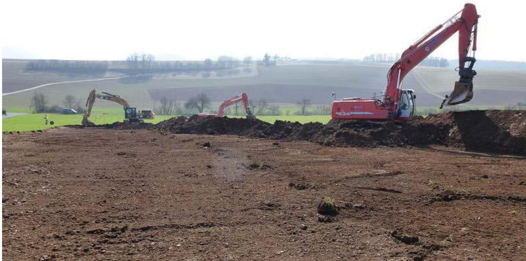
Abb. 3-5: Oberbodenabtrag zur Anlage eines Arbeitsstreifens, Quelle: OGE
