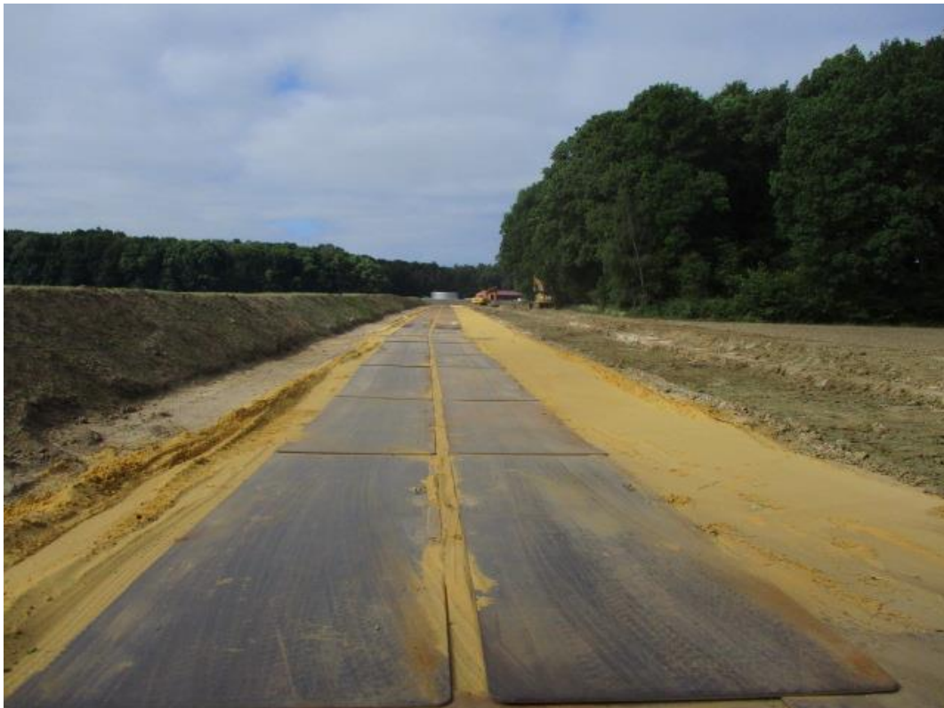
Abb. 3-6: Arbeitsstreifen mit Baustraße aus Stahlplatten auf Sandunterbau, Quelle: uventus
