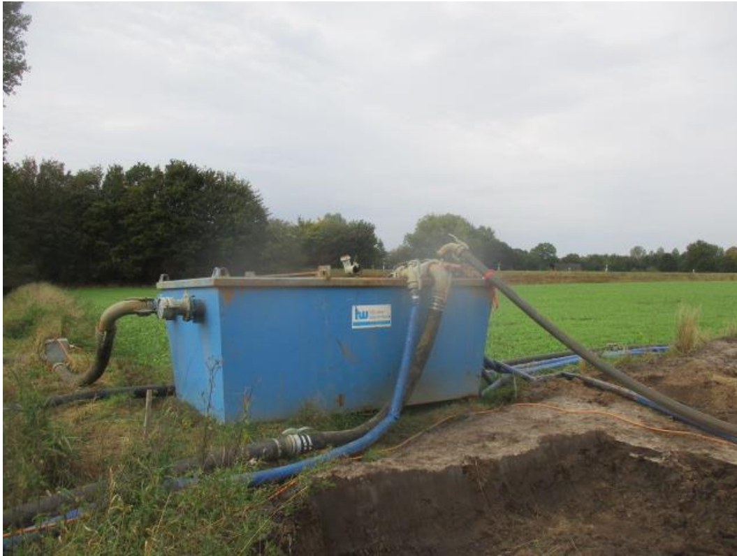
Abb. 3-9: Filterbecken für die Wasserhaltung, Quelle: uventus
