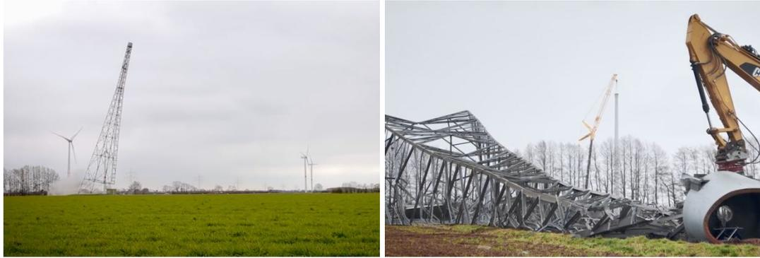
**Abbildung 12** Bilder der Sprengung (links) und Demontage eines Gittermastturmes (rechts) einer Vestas V47 in Bremen © Deutsche Windtechnik
