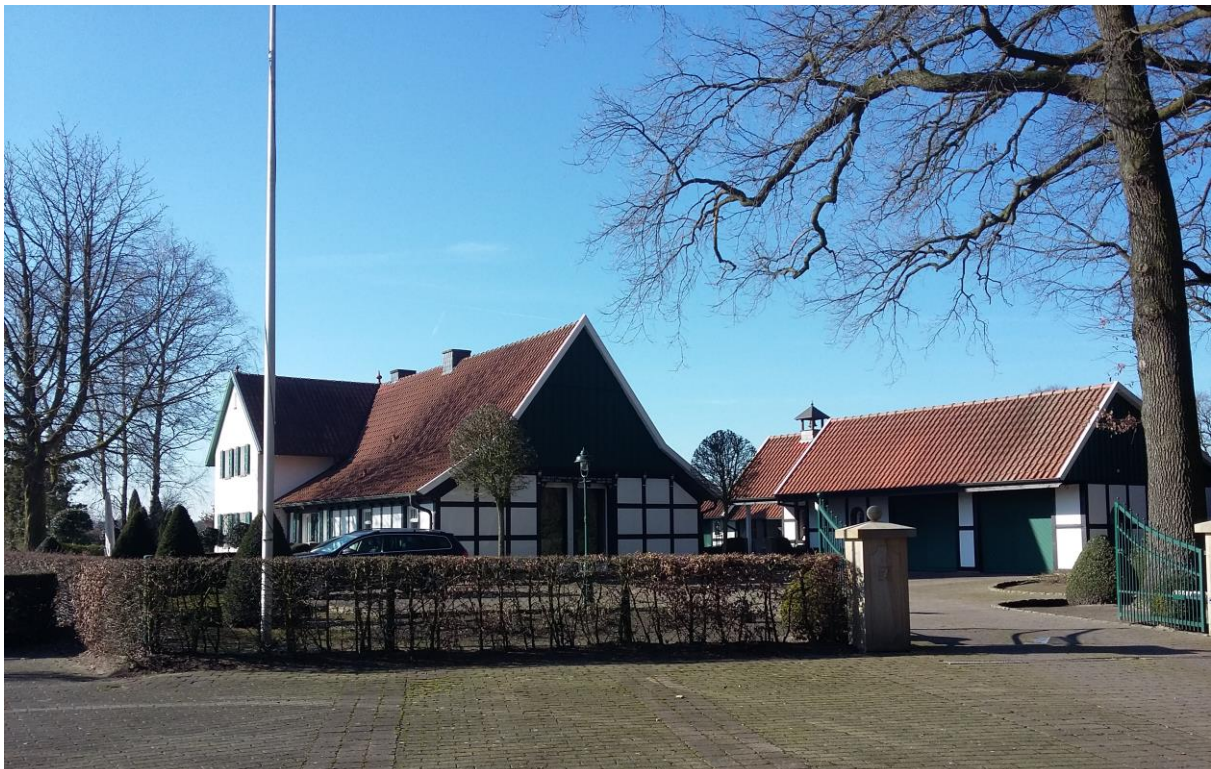
Abb. 7: IO 03 – Ansicht Grundstück und Gebäude
