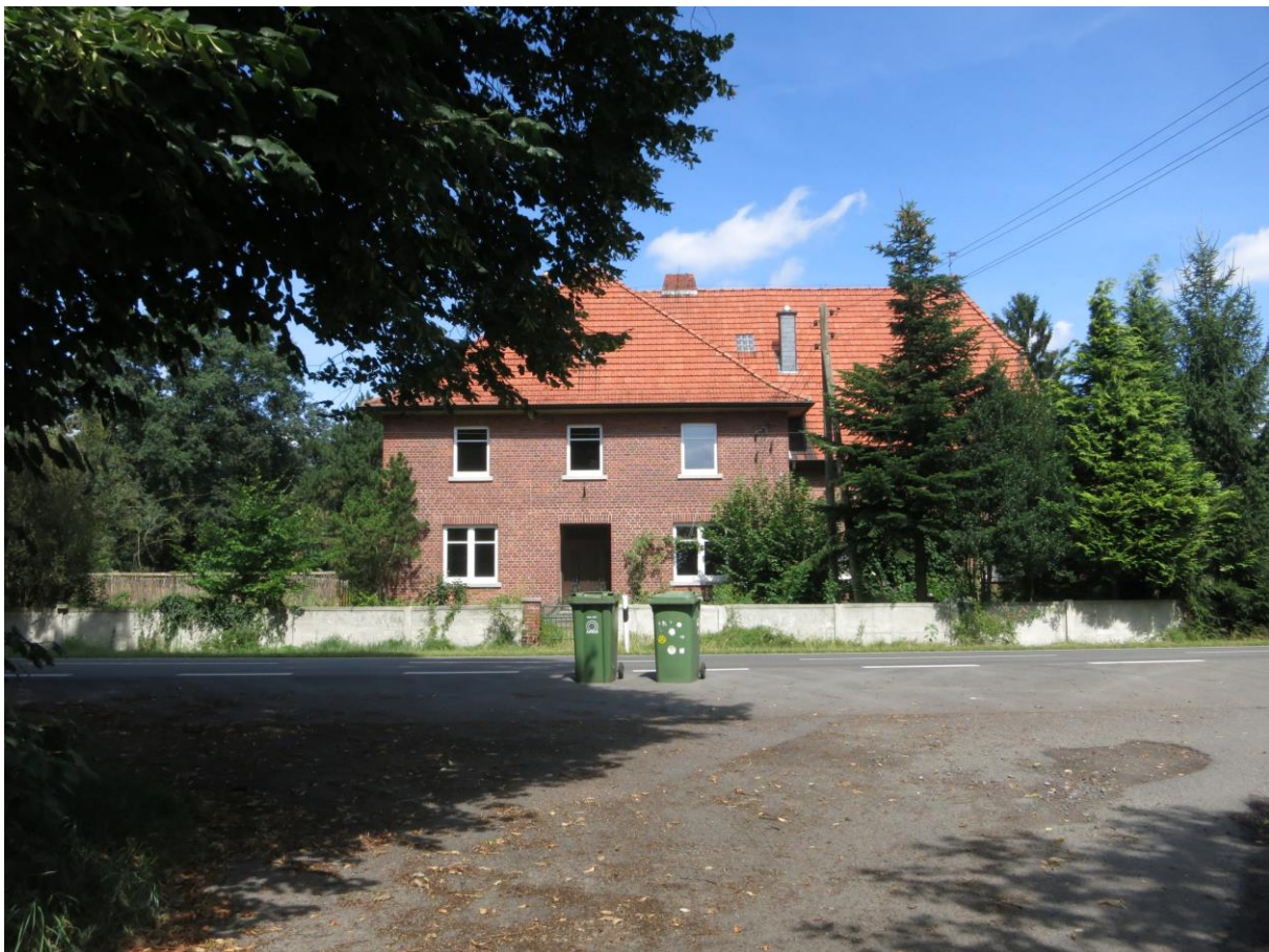
Abb. 15: IO 12 – Ansicht Grundstück und Gebäude
