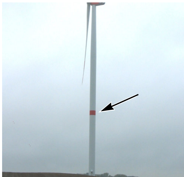
Abb. 4 Roter Farbring an Anlage mit Gesamthöhe >150 m
