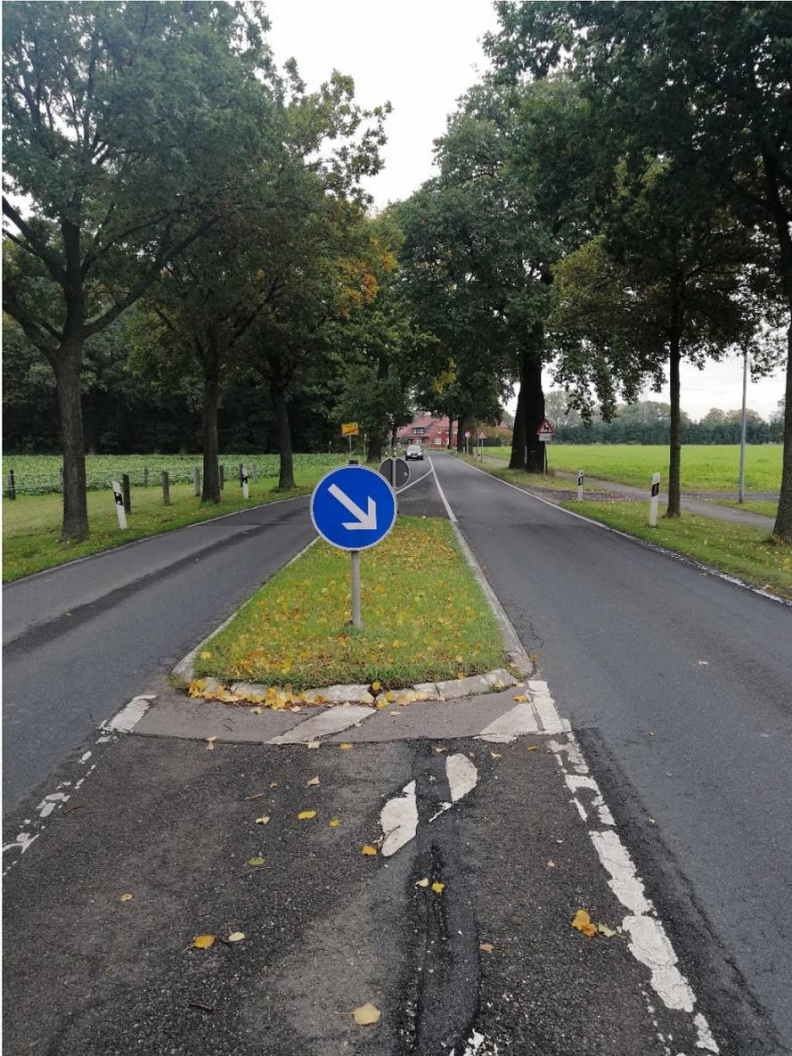
Abb. 2: Foto vorhandener Fahrbahnteiler
