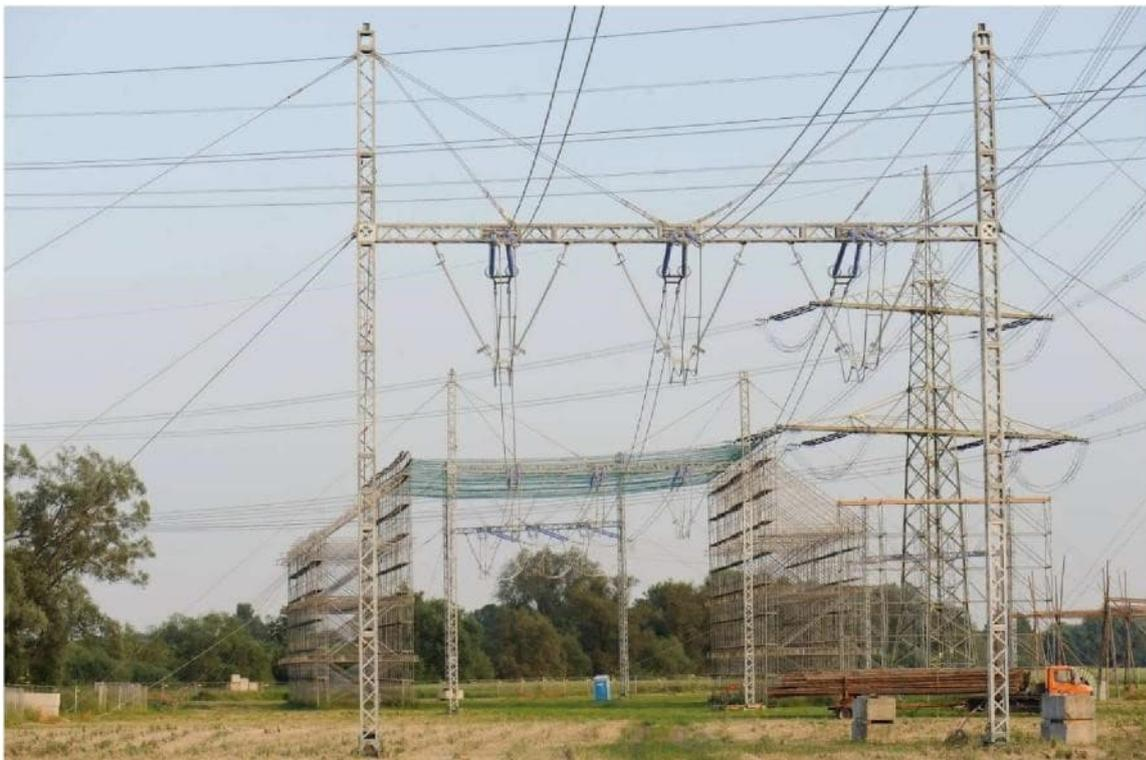
**Abbildung 4:** Einsatz von Provisorien (380 kV Freileitungsprovisorium für ein System, mit errichtetem Schutzgerüst im Hintergrund)
