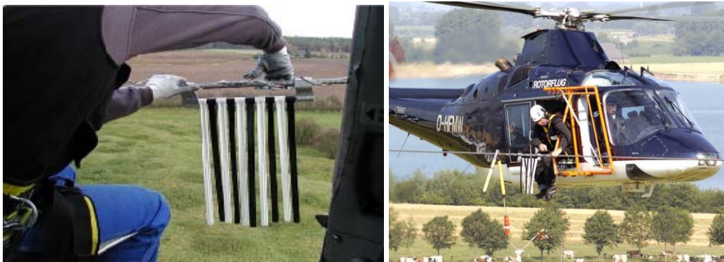
Abb. 13 Vogelschutzfahnen der Fa. Ribe® (aus BERNSHAUSEN et al. 2012)
