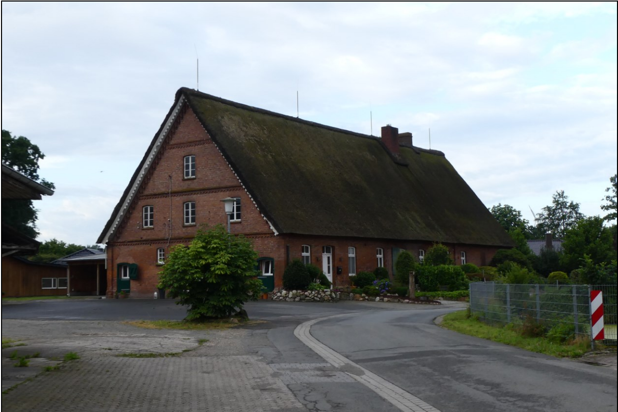
Abbildung 10: Sicht auf das Baudenkmal Nr.22 im Ist-Zustand.
