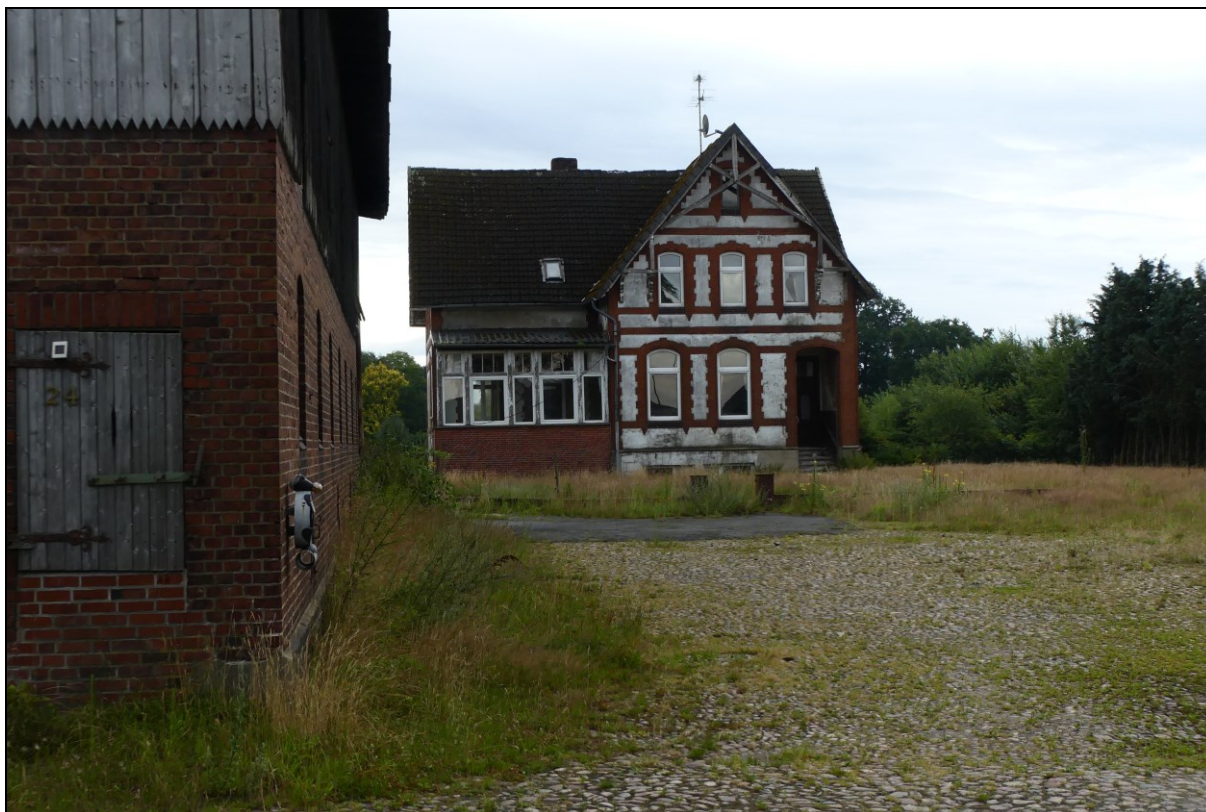
Abbildung 3: Sicht auf das Baudenkmal Nr.1 im Ist-Zustand.
