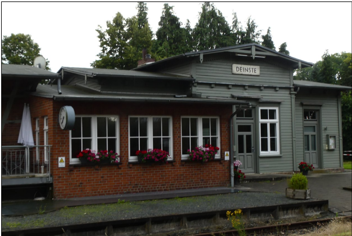
Abbildung 8: Sicht auf das Baudenkmal Nr.15 aus Sicht des Bahnsteigs.
