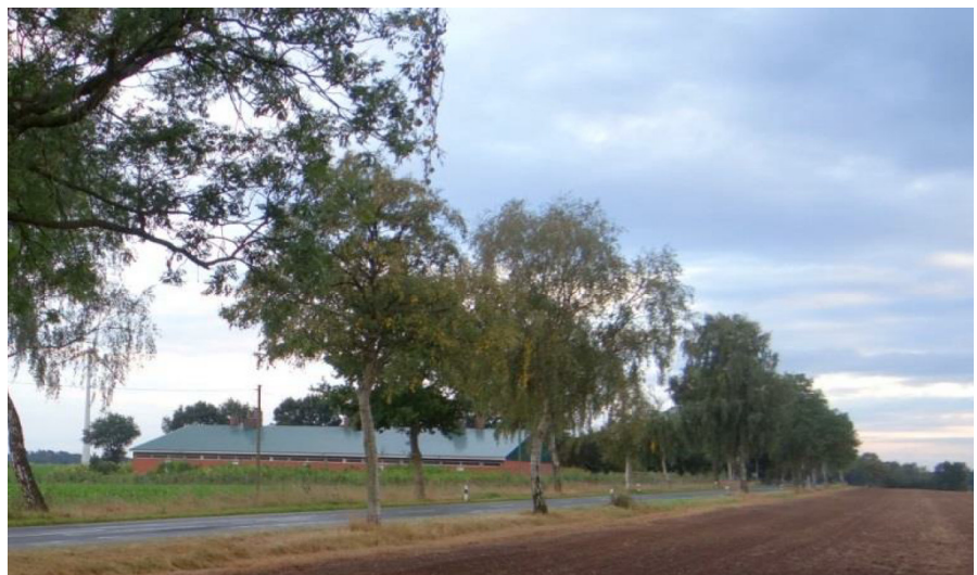
IPs26 (hinter dem Stallgebäude) aus Richtung Norden gesehen
