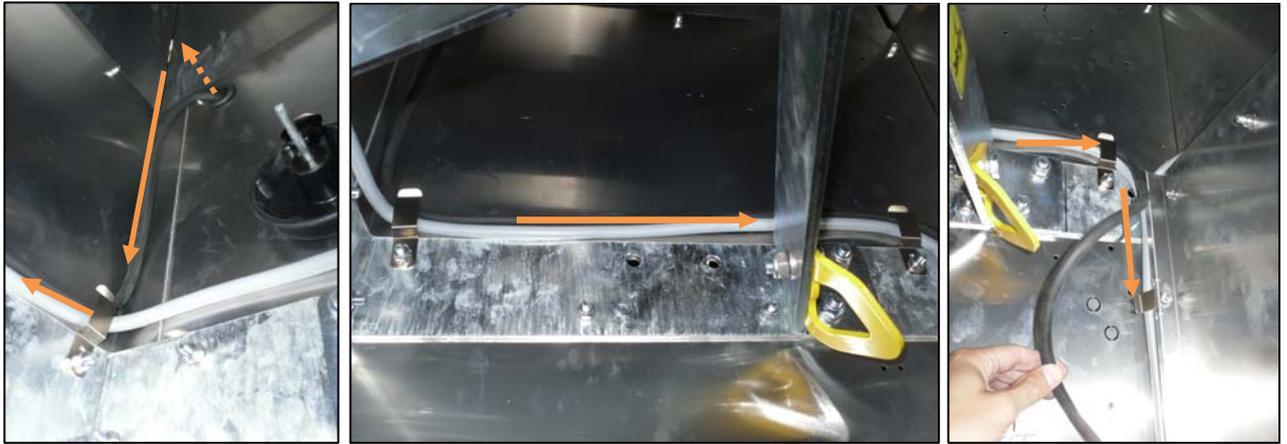
Führen Sie das Elektrokabel durch die Federklemmen im Inneren des Aufzugs, wie gezeigt. Stellen Sie sicher, dass ausreichende Kabellänge vorhanden ist, um den Stecker an dem Anschlusskasten zu erreichen (siehe Schritt 8)
