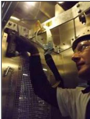
3. Verbinden Sie den zweiten Sicherheitshaken mit der Einhängeöse an der Außenseite des Aufzugs. Lösen Sie dann den Haken von der Einhängeöse in der Kabine und haken Sie sich an einem der Sicherheitsankerpunkte an der Leiter ein.
