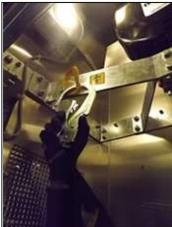
2. Drücken Sie manuell den Notriegelungsknopf des Türkontaktschalters (innerhalb oder außerhalb des Aufzugs).
