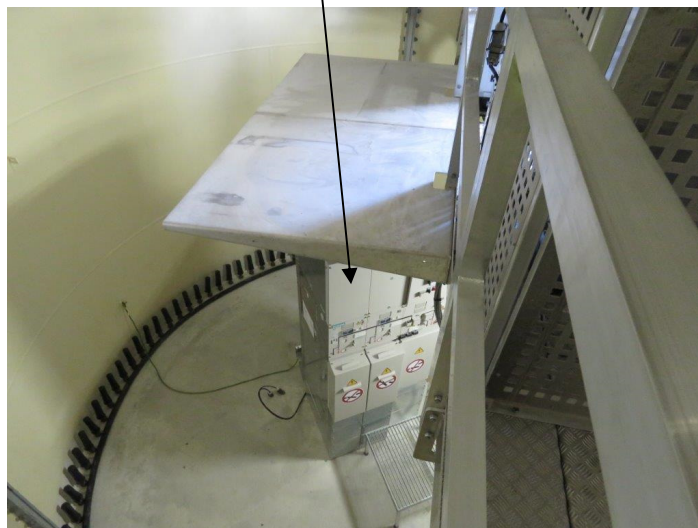
Abbildung 6: Photographische Darstellung des Turmfußbereich eines LDST Turmes
