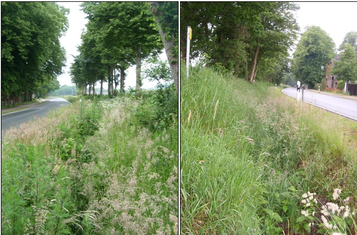
Abbildung 2: Gräben bei Maßnahmen 2 (links) und 3 (rechts). Diese Gräben führen nicht dauerhaft Wasser, weshalb die geplante Verrohrung hier unbedenklich ist.
