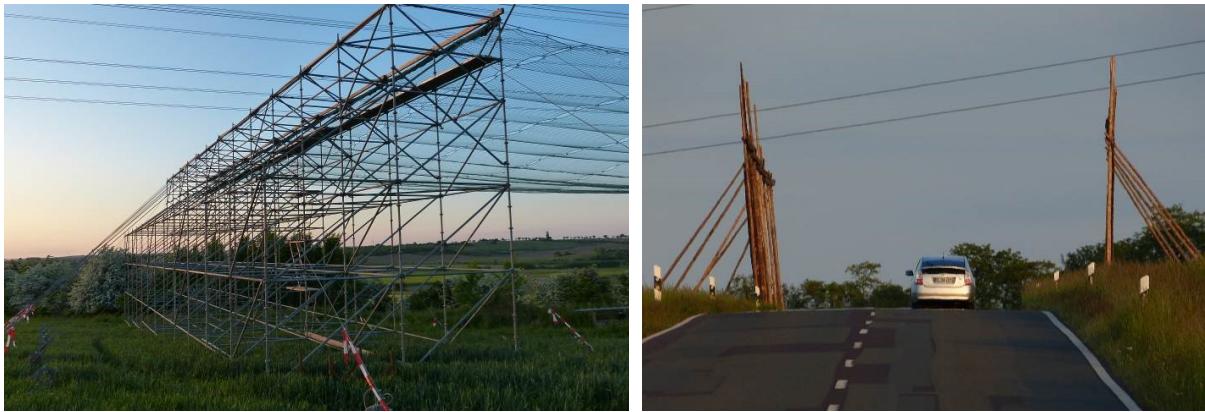
Abbildung 9: Beispiele für Schutzgerüste aus Stahl bzw. Holz
