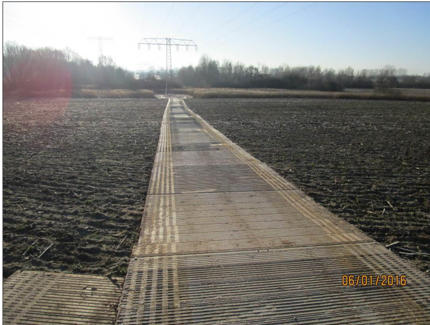
Abb. 3: Beispielhafter Wegebau mit Wegebauplatten
