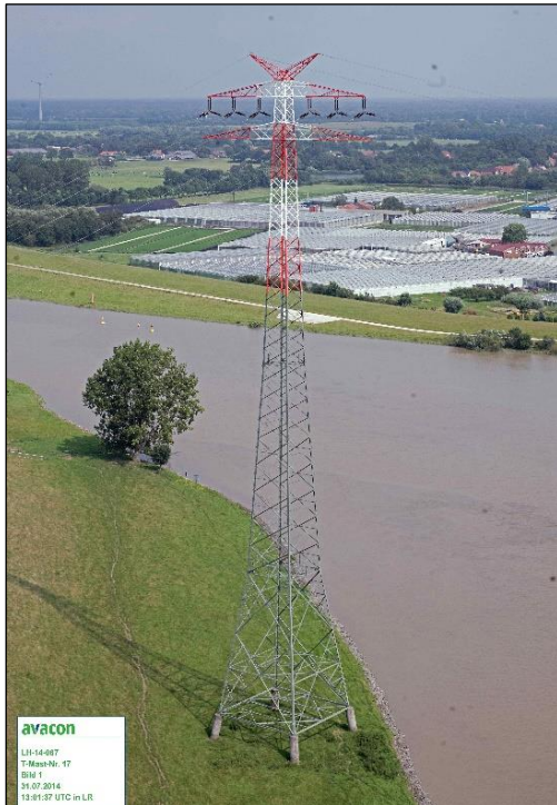
Abb. 4: Zu demontierender Mast Nr. 17 mit Doppel-Einebenengestänge und Erdseilhorn
