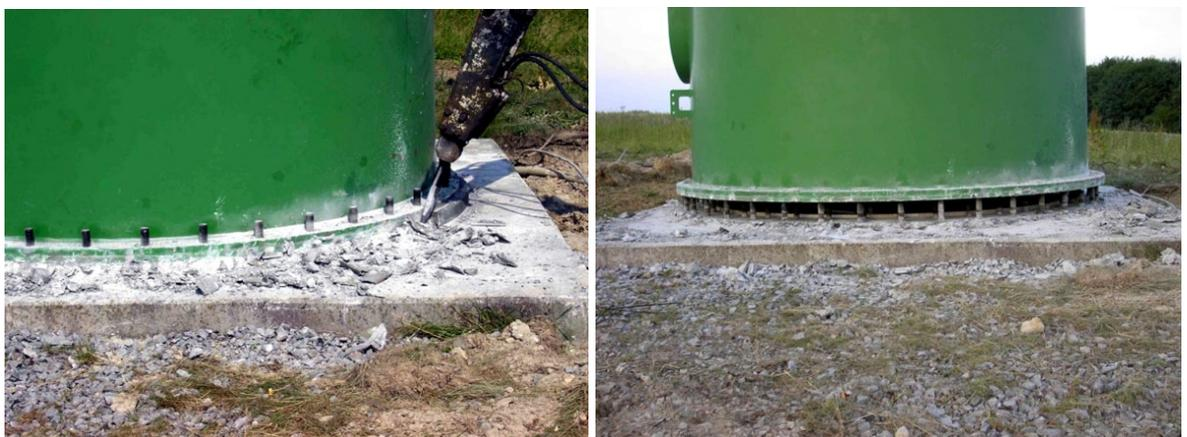
**Abb. 18: Trennen und Anheben der untersten Stahlsektion beim Turm mit Bolzenkorb**
