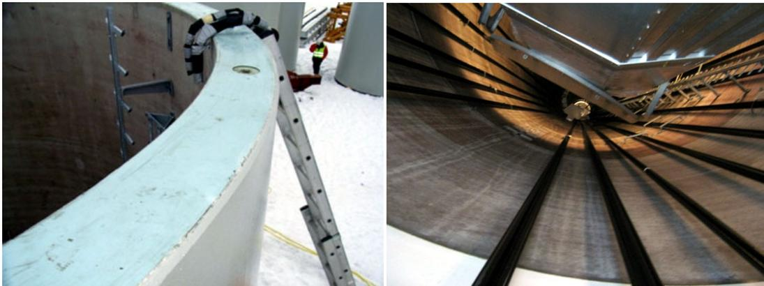
**Abb. 8: Horizontale Fuge geebnet (links), Spannglieder an der Turminnenseite (rechts)**
