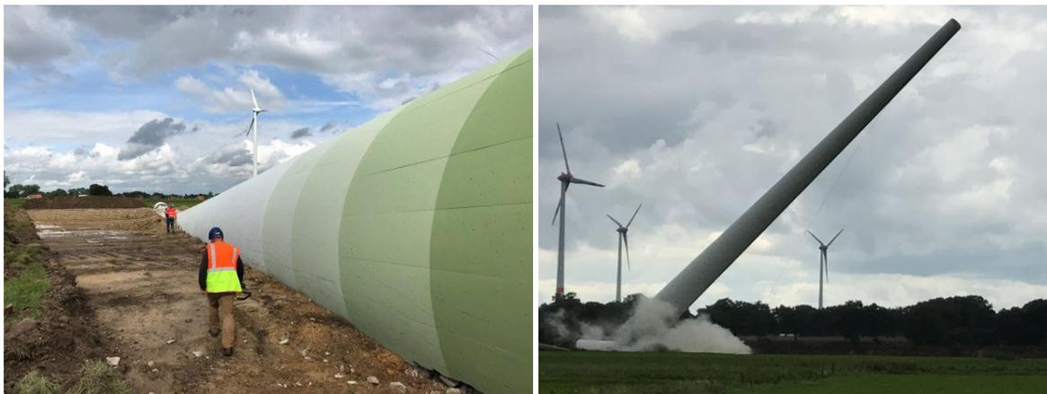
**Abb. 14: Umgelegter Turm (links), kontrolliertes Fallen des Turms (rechts)**
