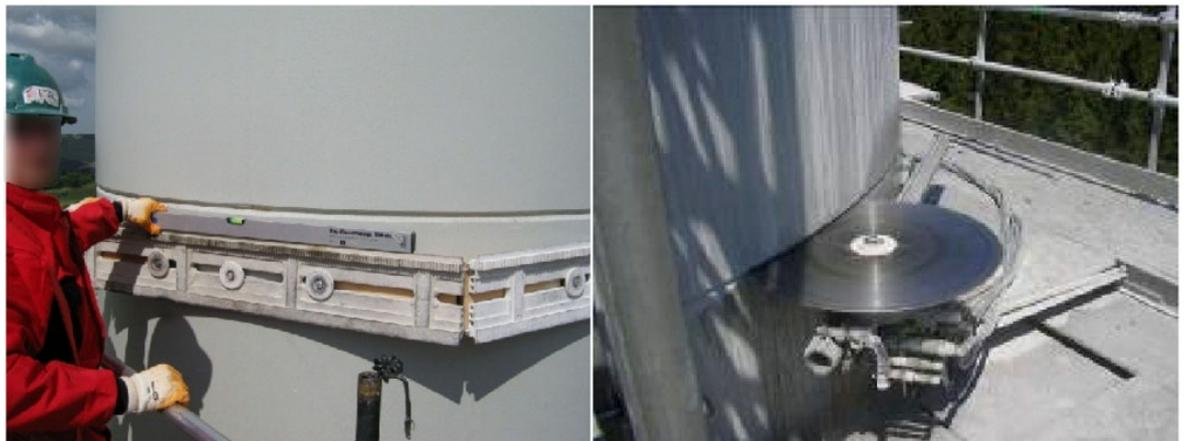
**Abb. 10: Führungsschiene für die Betonwandsäge am Segment verschraubt (links), Betonwandsäge (rechts)**
