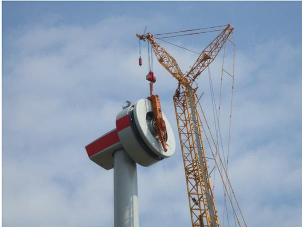
**Abb. 5: Generator-Rotor am Kran angeschlagen**
