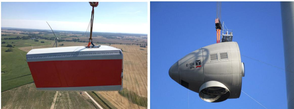
Abb. 6: Maschinenhäuser verschiedener Windenergieanlagentypen am Kran angeschlagen
