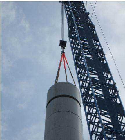
**Abb. 12: Angeschlagenes Betonsegment**
