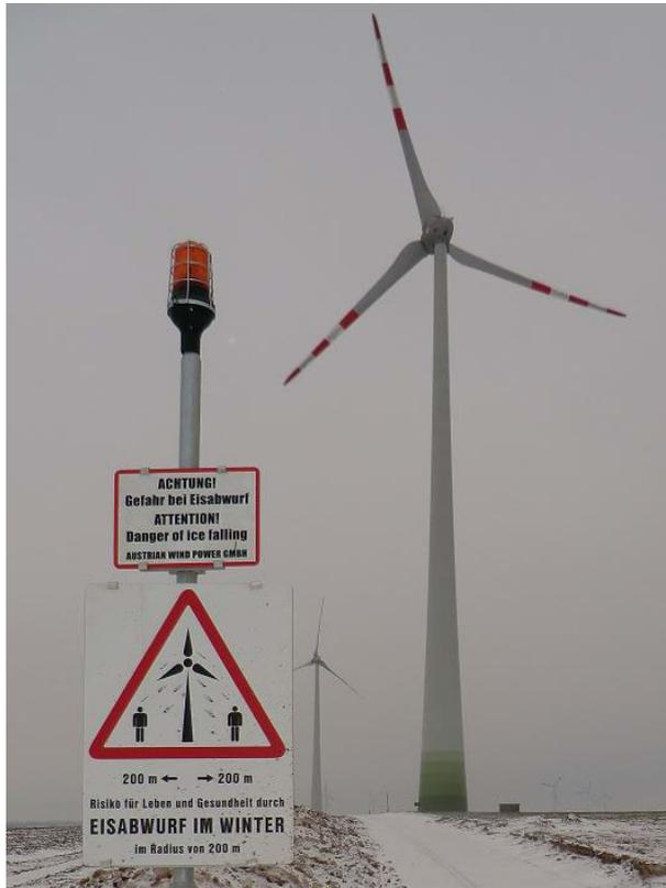
Abb. 1: Möglicher Aufbau einer Eiswarnleuchte mit zusätzlichen Warnschildern
