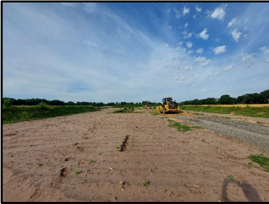
Foto 1: Schottereinbau im Bereich der Zuwegung Blickrichtung nach Westen Stand: 04.08.2022
