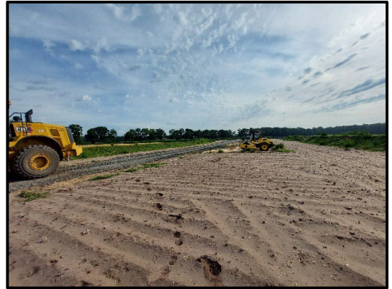
Foto 2: Schottereinbau im Bereich der Zuwegung Blickrichtung nach Osten Stand: 04.08.2022
