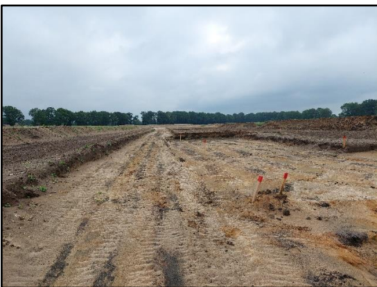
Foto 3: Zuwegung und Stellfläche Blickrichtung nach Osten Stand: 09.06.2022
