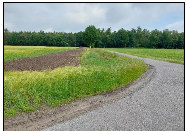
Foto 6: Kreuzung „Linnenkamp“ / „Weidenweg“ Vorgesehene Kurvenverbreiterung links Blickrichtung nach Norden Stand: 09.06.2022
