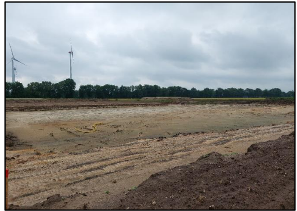
Foto 4: Zukünftige Kranstellfläche Blickrichtung nach Südwesten Stand: 09.06.2022
