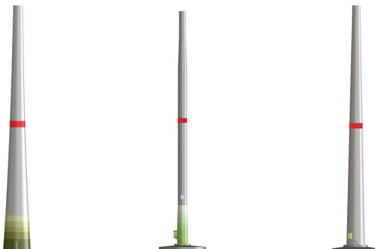
**Abb. 7: Farbliche Kennzeichnung am Turm, beispielhafte Darstellung**
