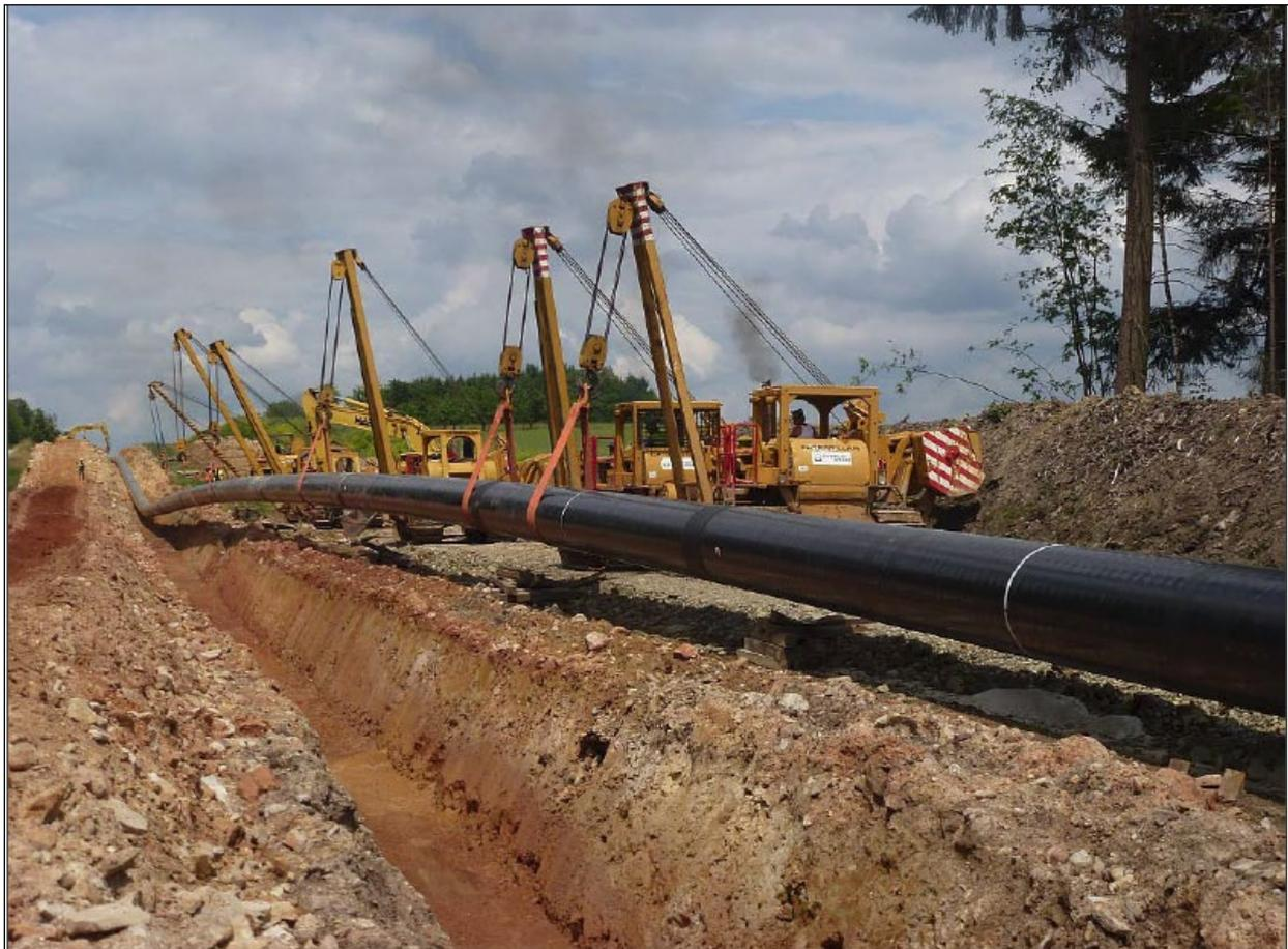
**Abbildung 10: Absenken des Rohrstranges**
