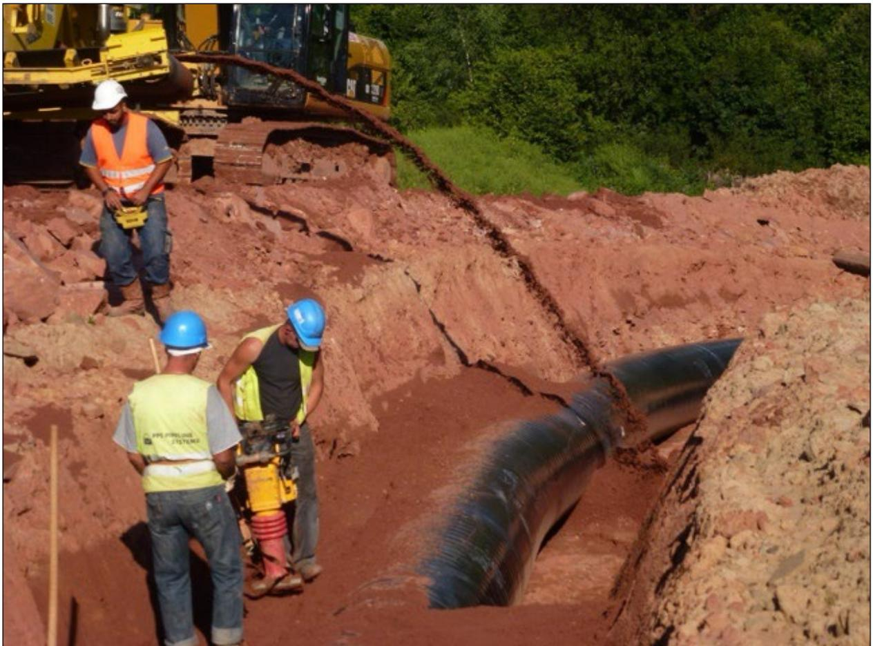
**Abbildung 11: Verfüllen des Rohrgrabens**
