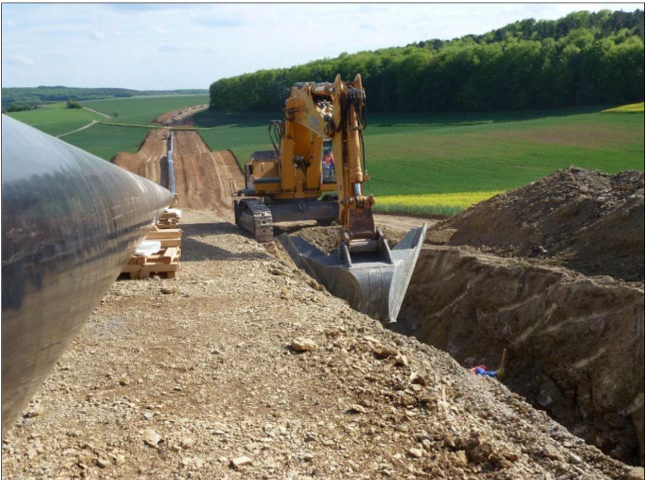
**Abbildung 9: Aushub des Rohrgrabens**
