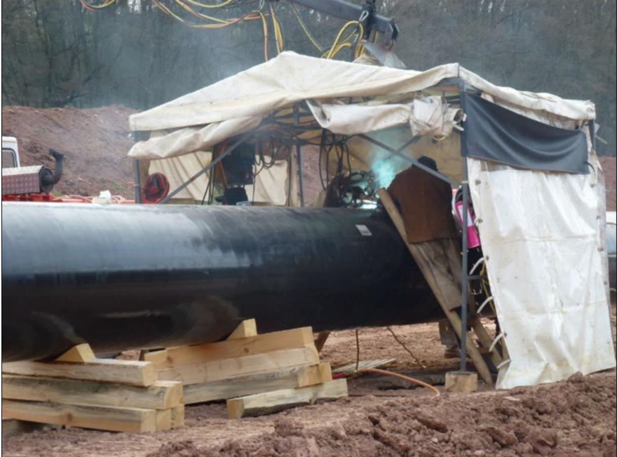
**Abbildung 8: Verschweißen der Rohre zum Rohrstrang**
