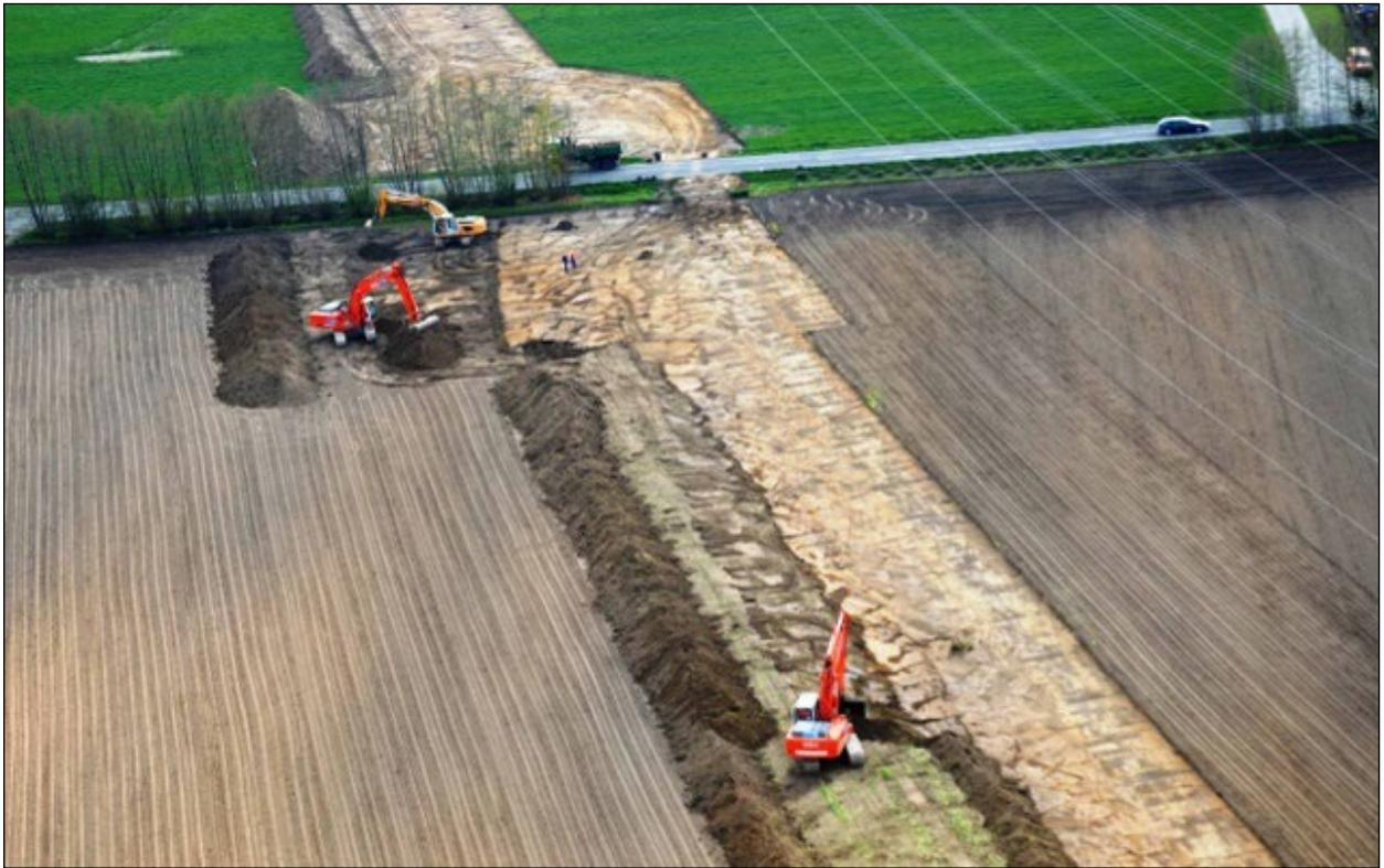
**Abbildung 6: Abheben und Lagern des Mutterbodens (Oberboden)**
