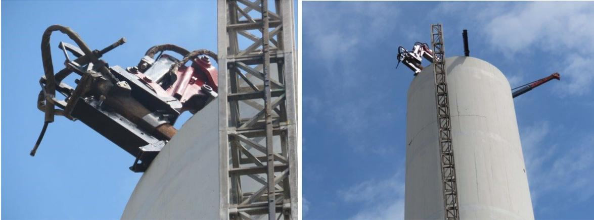
**Abb. 16: Abb: Aufsetzbagger mit Meißel (links), Aufsetzbagger am Turm (rechts)**
