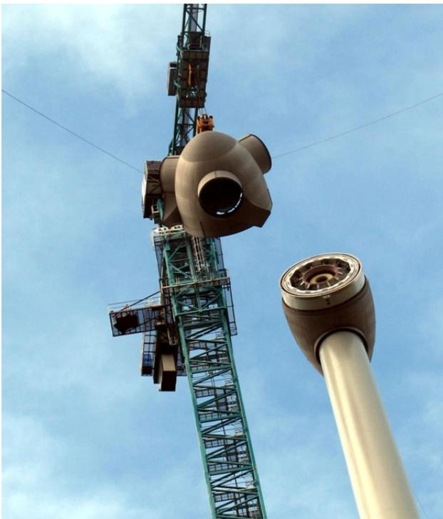
**Abb. 4: Rotorkopf angeschlagen**
