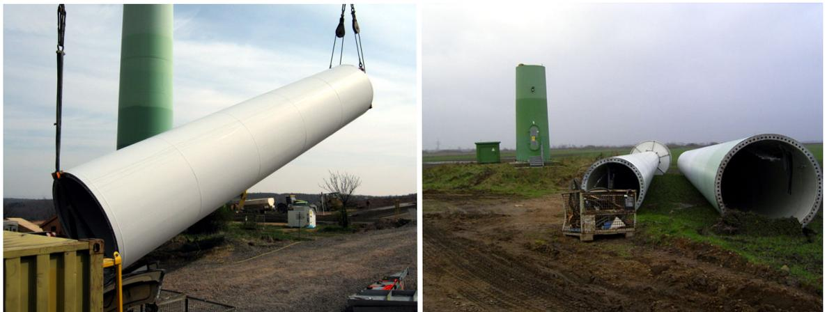
**Abb. 17: Stahlsektion beim Ablegen (links), demontierte Stahlsektionen (rechts)**
