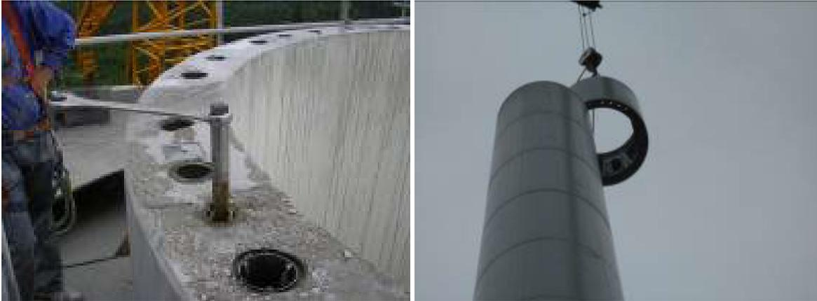
**Abb. 11: Nachschneiden beschädigter Gewinde (links), Herunterheben einzelner Segmente (rechts)**
