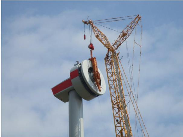
**Abb. 5: Generator-Rotor am Kran angeschlagen**
