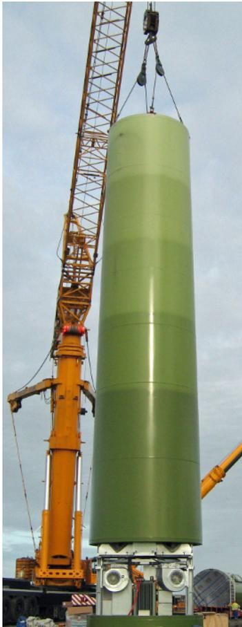
**Abb. 7: E-Modul unter einer angeschlagenen Stahlsektion**
