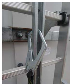
3 Bei einer Hailo® Sicherheitssteigleiter mit einer Steigschutzschiene von LMB im C-Profil-Langloch mittels Rohrhaken
