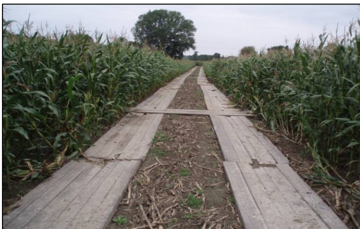
Abb. 3.3-1 Temporäre Zuwegung über Fahrbohlen (AMPRION 2015)
