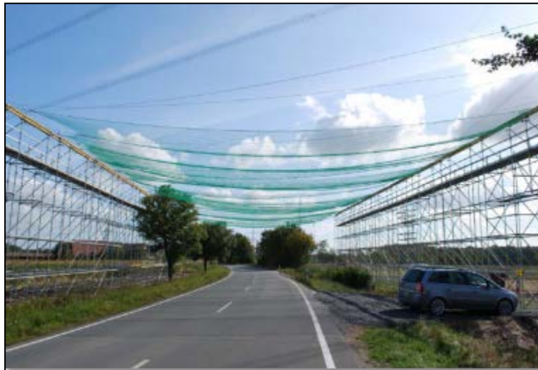
Abb. 3.3-8 Stahlrohrschutzgerüst mit Netz über einer klassifizierten Straße
