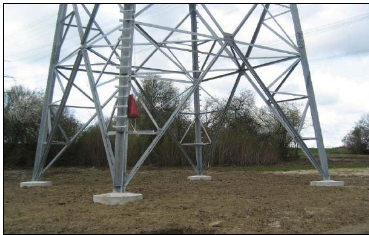
Abb. 3.3-6 Mastunterteil eines Plattenfundamentes nach der Verfüllung
