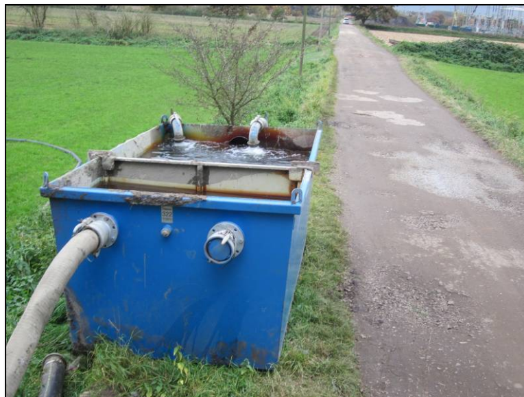
Abb. 4.2-1 Maßnahmen zum Gewässerschutz - Absetzbecken
