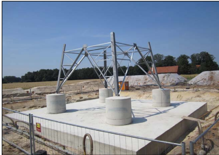
Abb. 3.3-5 Plattenfundament vor der Verfüllung
