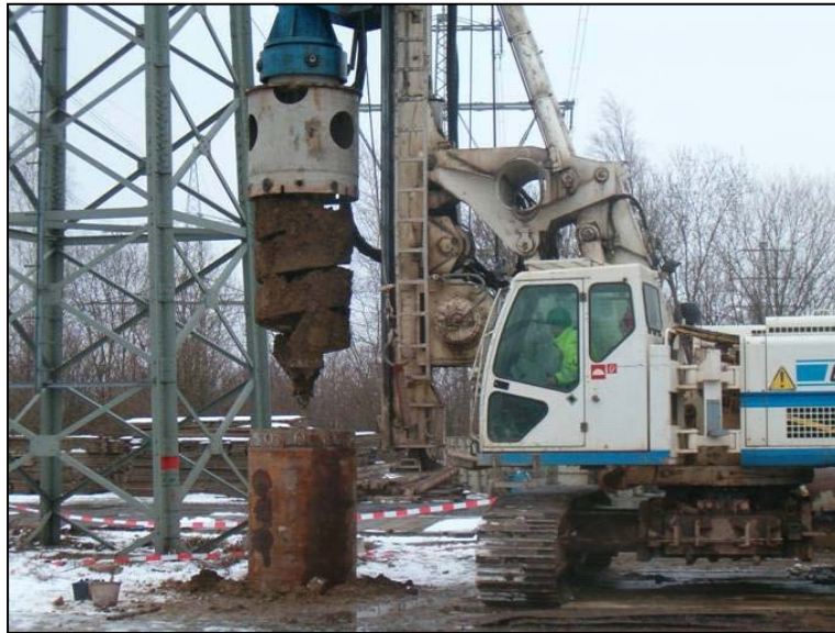
Abb. 3.3-3 Bohrung für ein Bohrpfahlfundament
