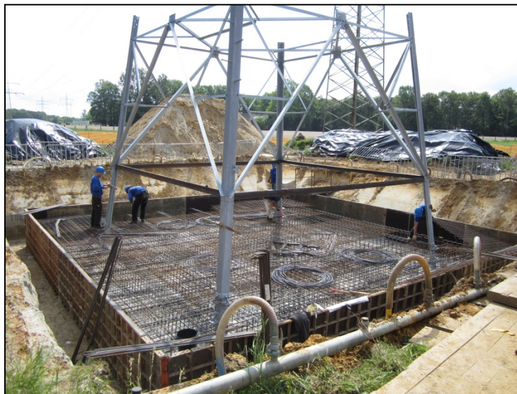
Abb. 3.3-4 Betonieren der Fundamentplatte eines Plattenfundamentes
