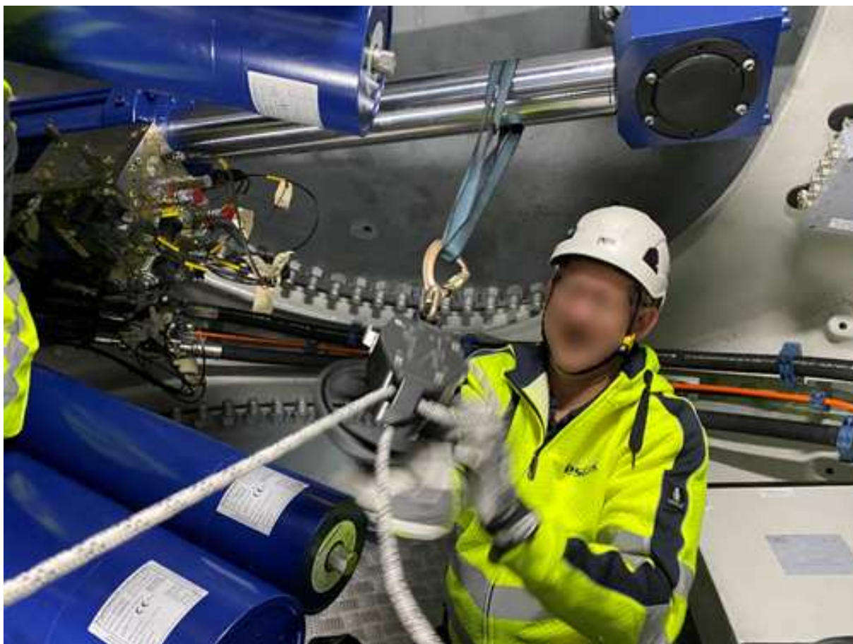
Abbildung 7.27: Befestigung der Notabstiegsvorrichtung am Pitchzylinder
