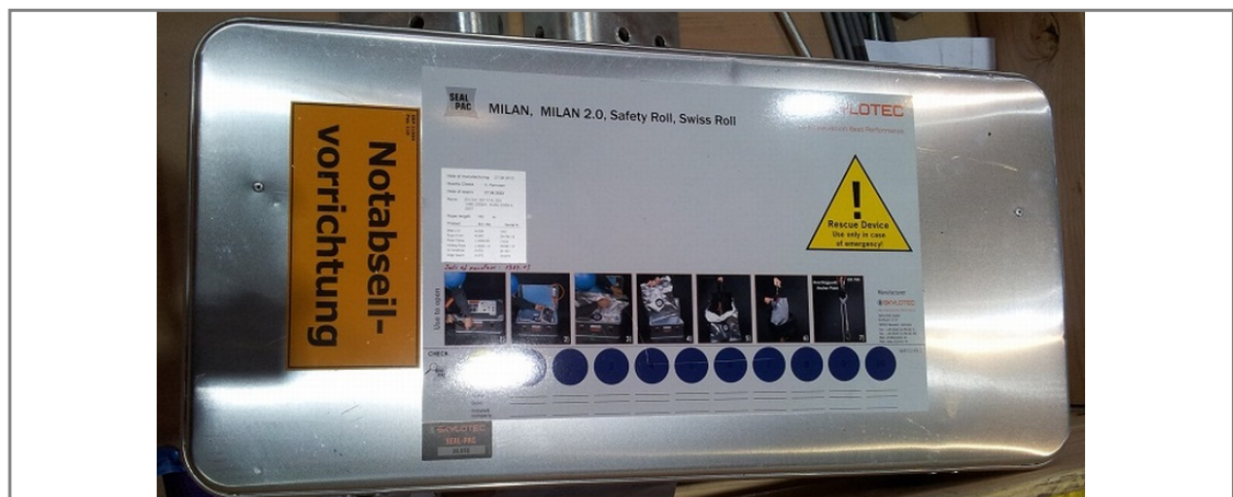
Abb. 3: Notabseilausrüstung in der WEA
