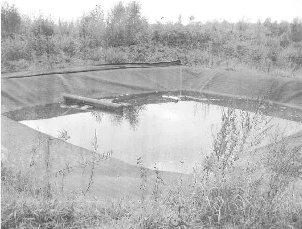
Abb. 2.6: Speicherbecken Niederschlagswasser Ost mit Überlauf
