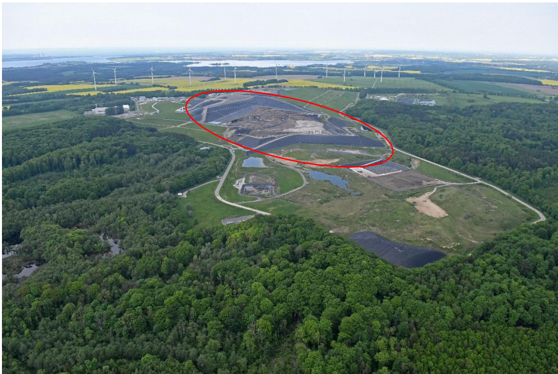
Abbildung 2-1: Luftbild der Deponie Ihlenberg (Blickrichtung SW – NE). Die rote Ellipse kennzeichnet (grob) den derzeit zur Ablagerung von Abfällen genutzten Bereich des Deponiekörpers. (Bildquelle: IAG)
