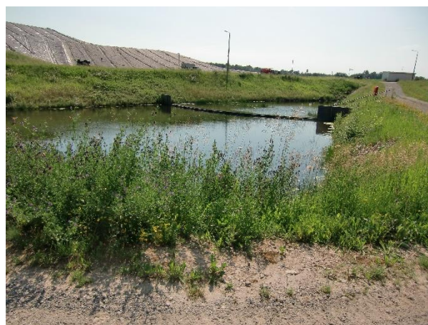
Abbildung 7-4: Regenrückhaltebecken (RHB) West, Lage im Westen der Deponie
