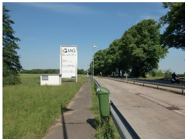
Abbildung 7-2: Einfädelungsspur im Eingangsbereich der Deponie Ihlenberg
