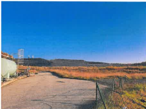
Blick auf den Deponiekörper aus Richtung Süd
