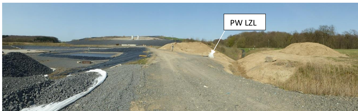
Abbildung 4: Betriebsweg zwischen Landzeitlager (links) und RHB Ost IV (rechts)
