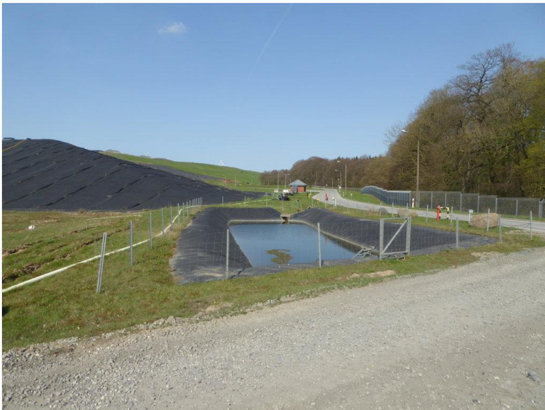
Abbildung 6: Bestehendes Folienbecken vor Ablauf Ost IV - RWBA
