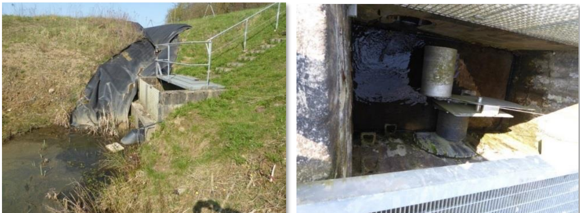
Abbildung 2: Vorhandene Ablaufdrossel am Ablauf Ost IV
