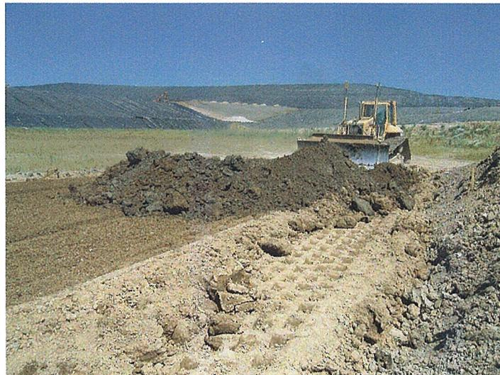
Einschieben einer neuen Lage mit Dichtungsmaterial
