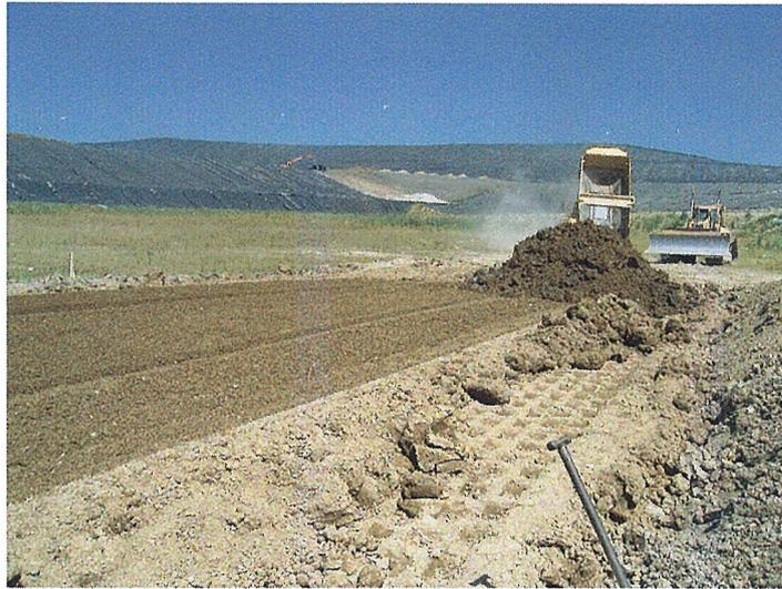
Einschieben einer neuen Lage mit Dichtungsmaterial
