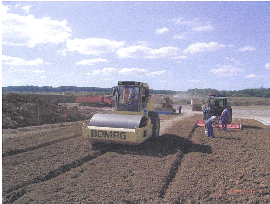
Bild 7: Verdichtung der 1. Einbaulage 2, 4 und 6 Verdichtungsübergänge
