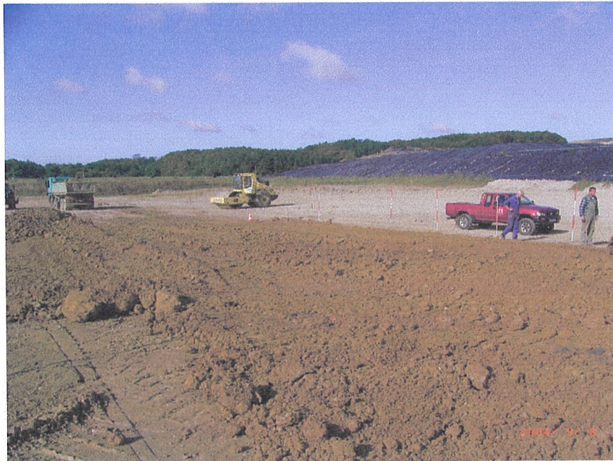
Bild 3: Herstellung der 1. Einbaulage
