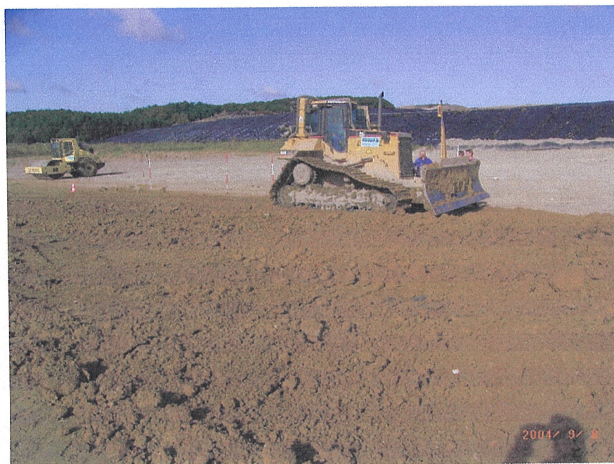
Bild 4: Herstellung der 1. Einbaulage
