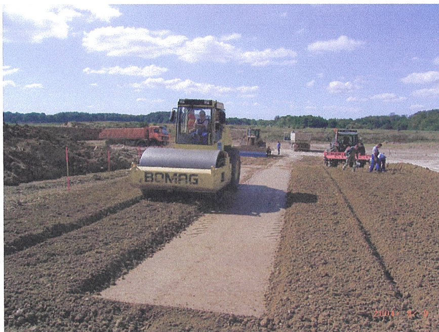
Bild 8: Verdichtung der 1. Einbaulage
