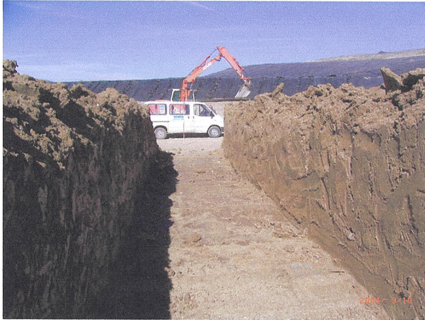
Bild 9: Probeschurf nach dem Aufbau und Verdichten der 6 Einbaulagen
