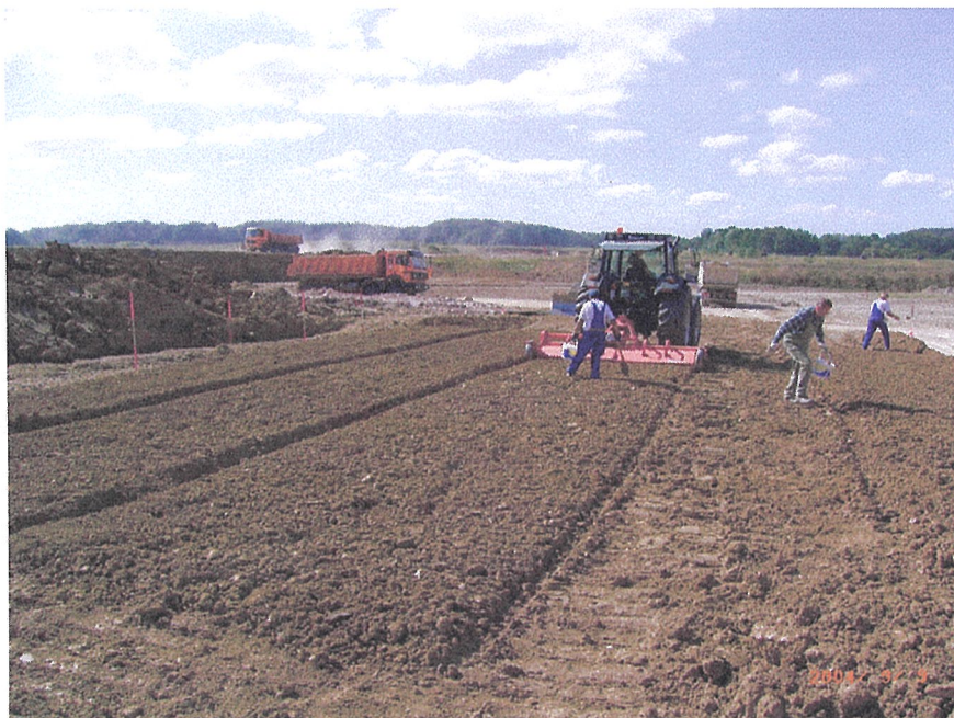
Bild 6: Fräsen der 1. Einbaulage und Steine sammeln vor der Verdichtung
