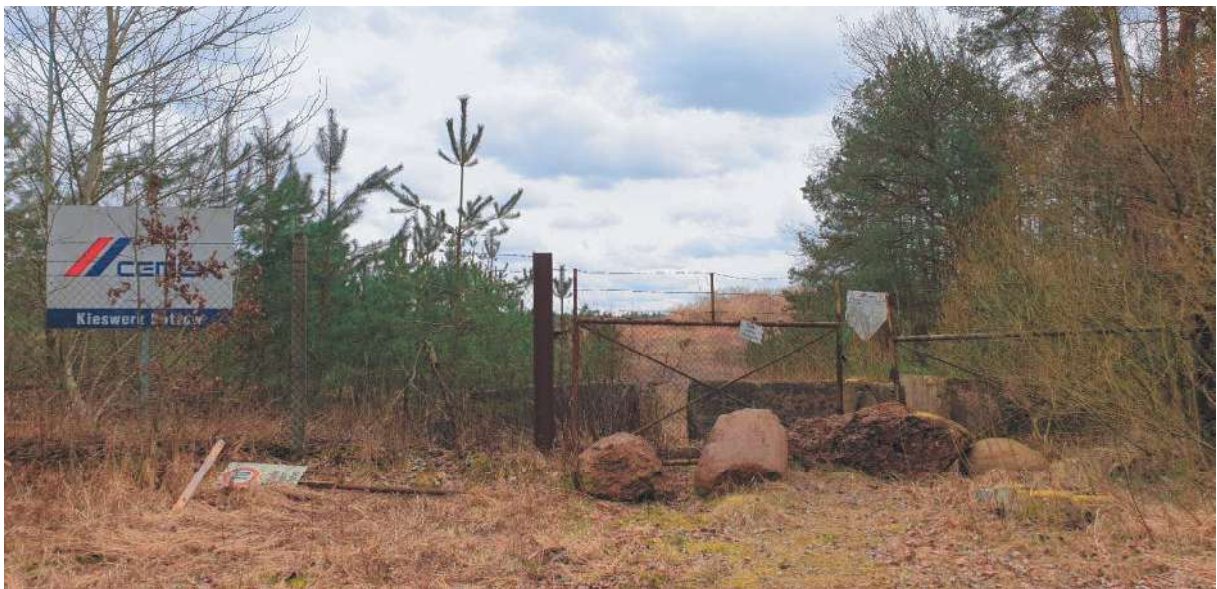
Umzäunung und Eingangsbereich des Kiessandtagebaus, Blickrichtung Nordost
