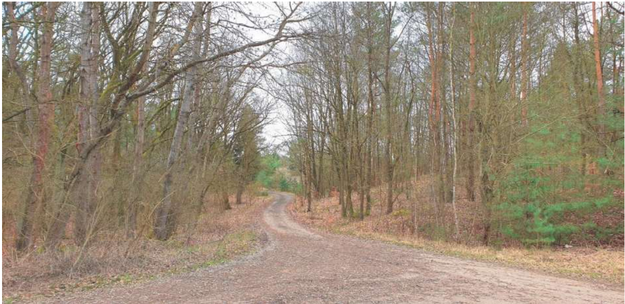
Unbefestigte Anfahrtsstraße zum Kiessandtagebau Kotzow, Blickrichtung Südwest
