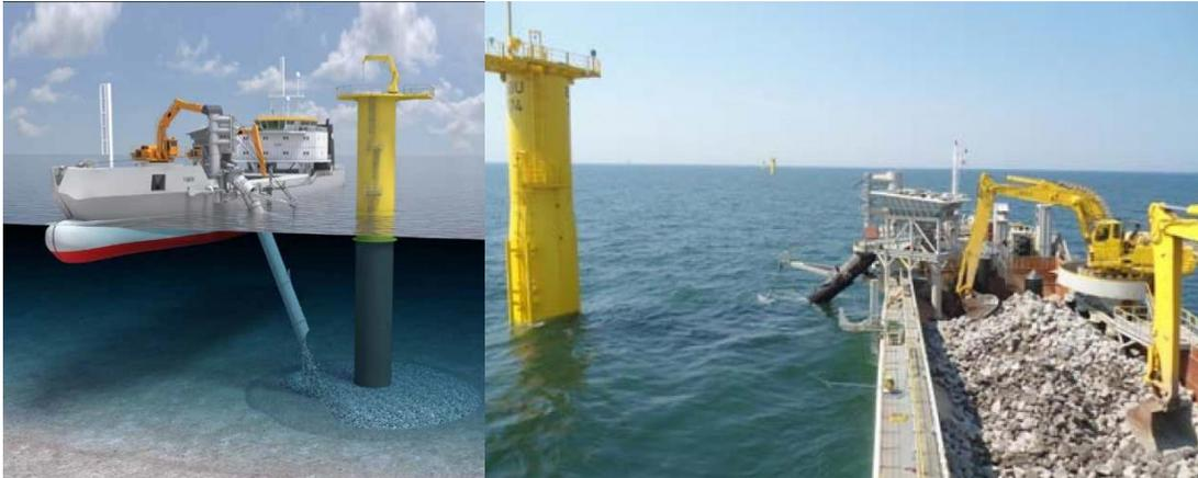
Abbildung 2: Beispiel eines Fall-Pipe Vessels, Einsatz beim OWP Butendiek; Quelle: [www.heavyliftnews.com](http://www.heavyliftnews.com) / Jan de Nul
