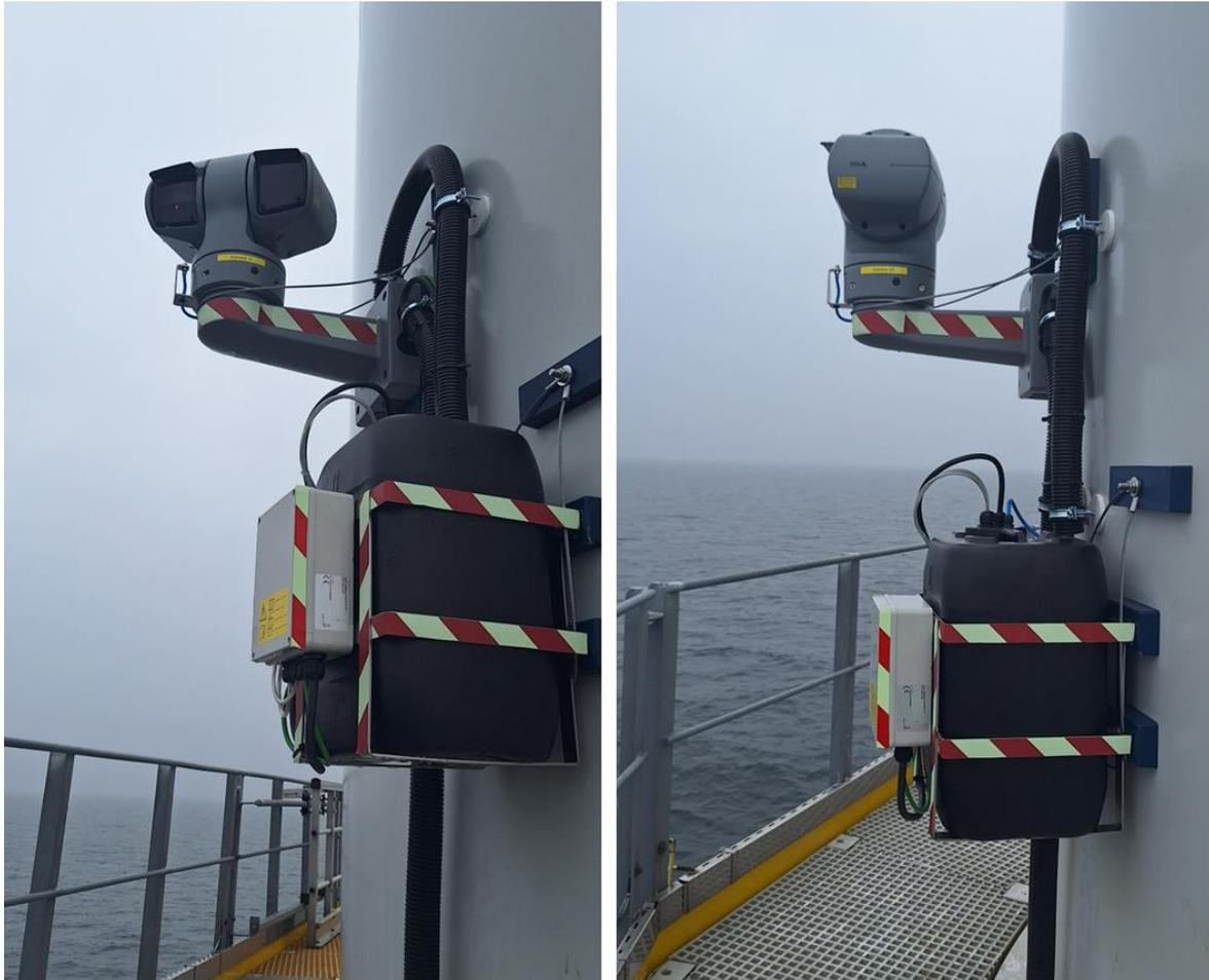
Abbildung 8: Beispiel für eine montierte PTZ-Kamera mit Wischwassertank an einer Offshore-WEA.
