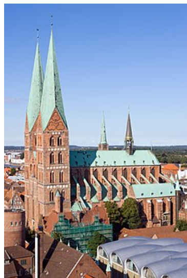
Abb. 5 Südansicht der Lübecker Marienkirche mit dem Strebewerk über dem Seitenschiff“ 34
