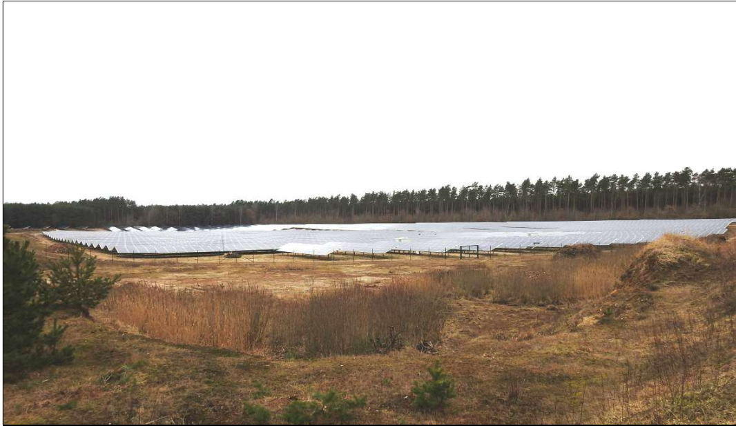
Foto 13: Photovoltaikfeld angrenzend an die Meyenburger Tannen
