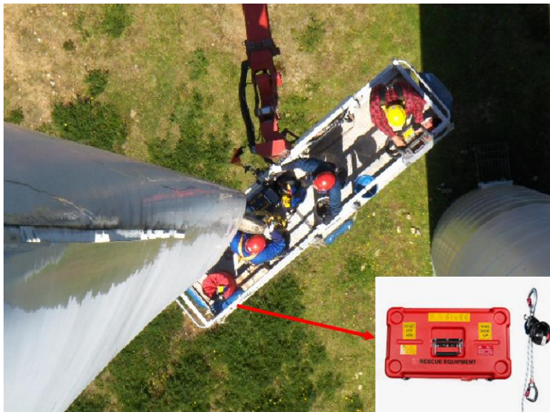
Abbildung 10-1: Beispiel für einen Notabstieg an einem Mannkorb
