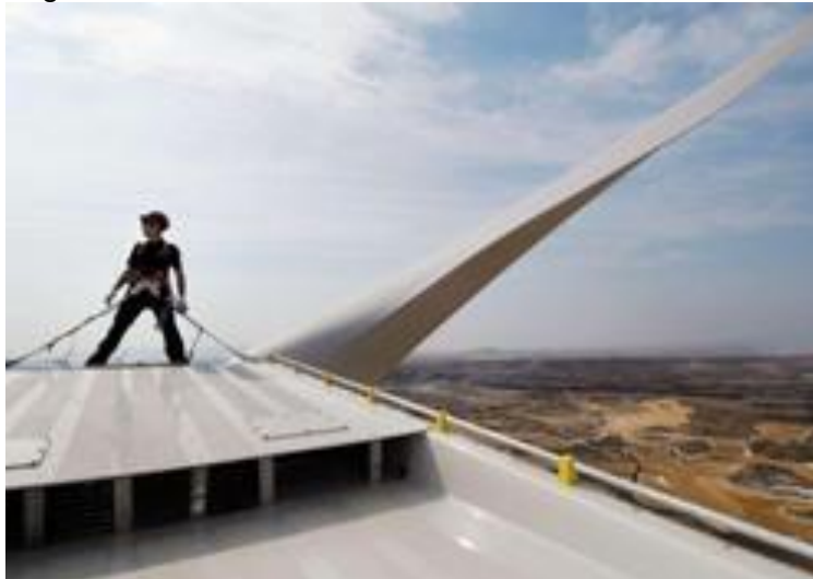
Abbildung 10-2: Arbeiten auf dem Maschinenhaus
