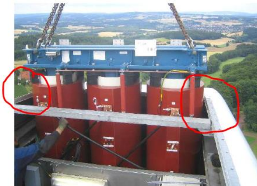
Abbildung 18-1: Führen des Transformators in das Maschinenhaus
