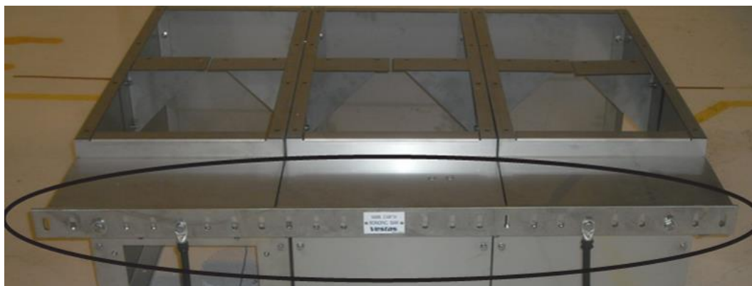
Abbildung 2-3: Auf der Rückseite eines Grundrahmens mit drei Konsolen montierte Haupterdungsschiene.
