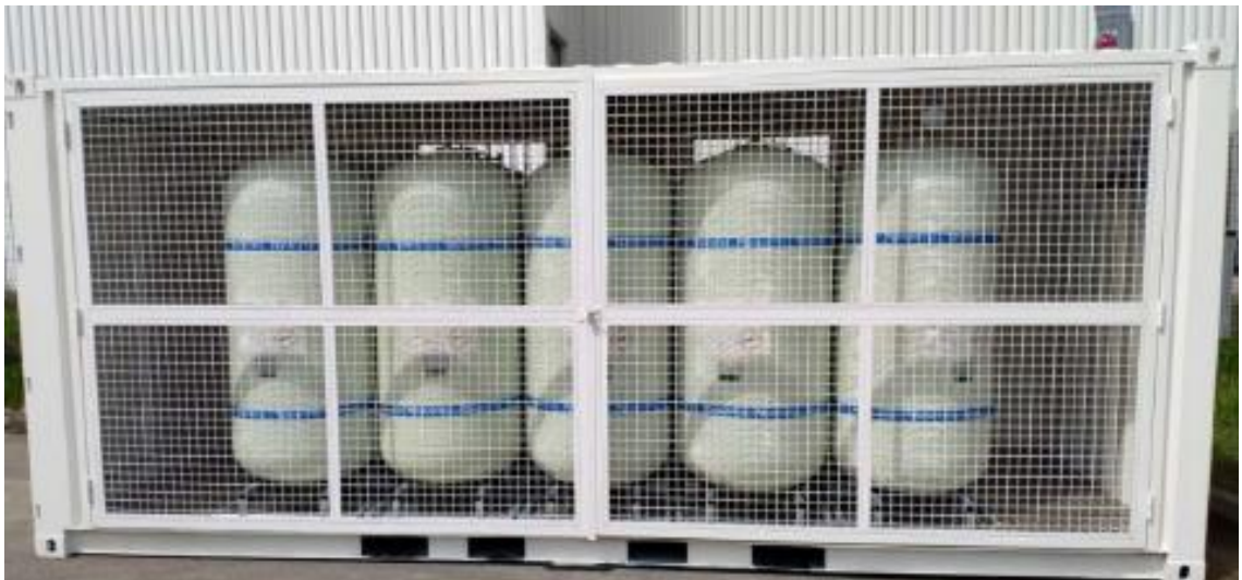
Abbildung 3: Wasserstoffspeicher 30 bar – BE2, Quelle: APEX-Zeich.-Nr.: 91-00001 Version 0; Stand: 26.05.2021
