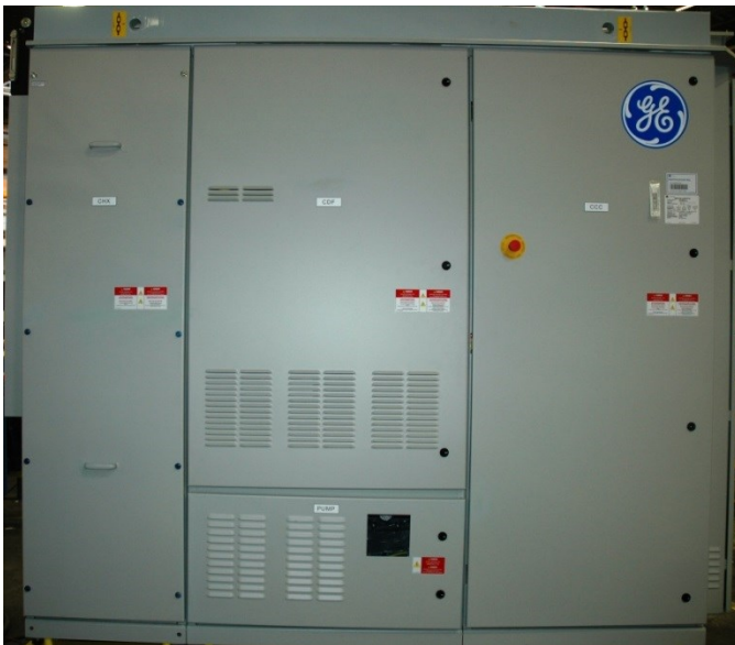
Abbildung 1: Vorderansicht des DFIG-Umrichterschrankes (Wärmetauscher-, Distortionfilter-, Pumpen- und Umrichtersteuerungsschrank)
