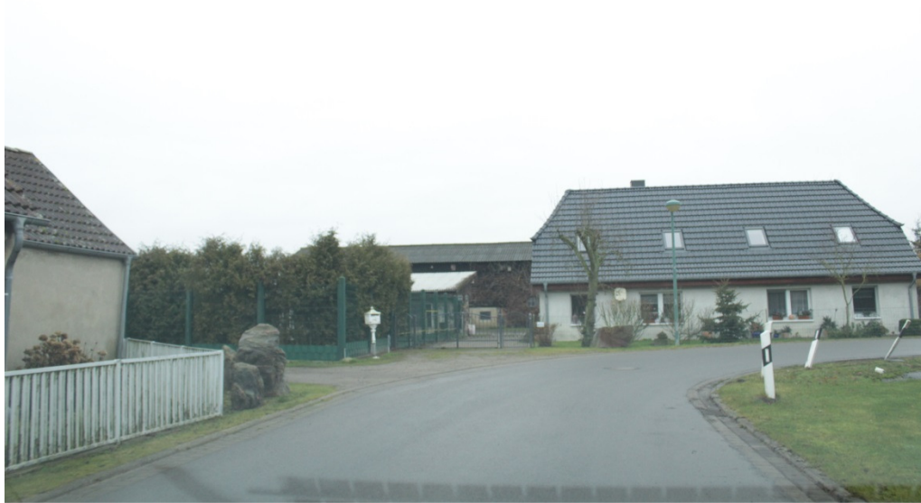
IP CT und IP CU: Whs. Klitschendorf 10 und Nebengebäude, Klein Bünzow
