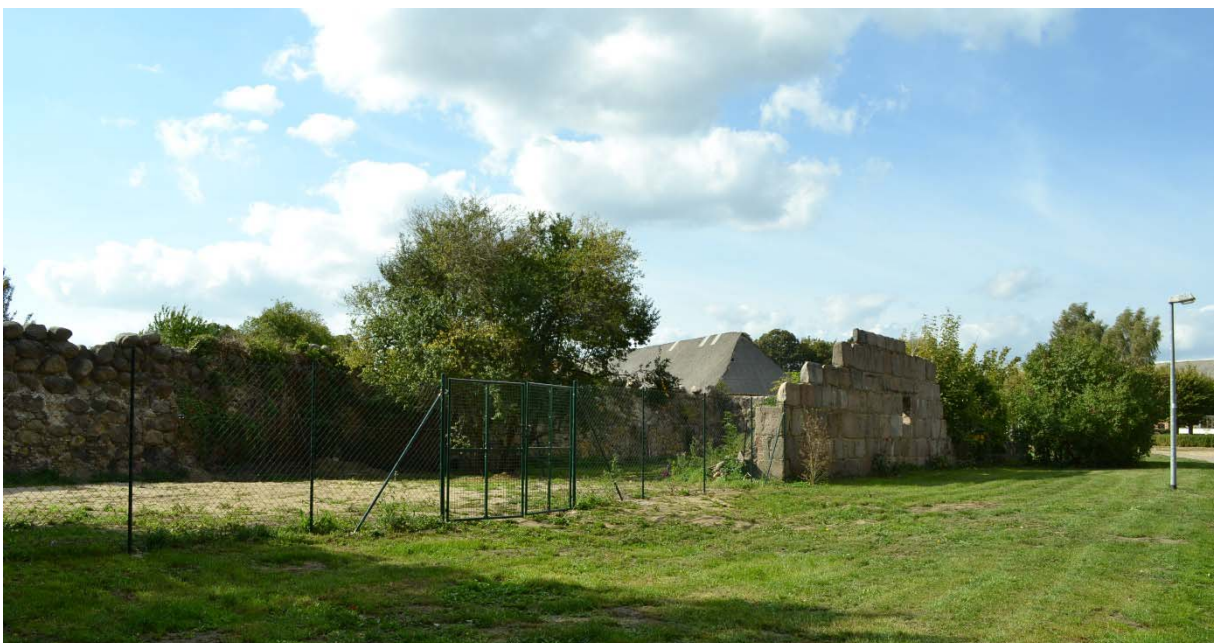
Abbildung 36: ehemaliger Stallspeicher, eigenes Foto vom 21.09.2018
