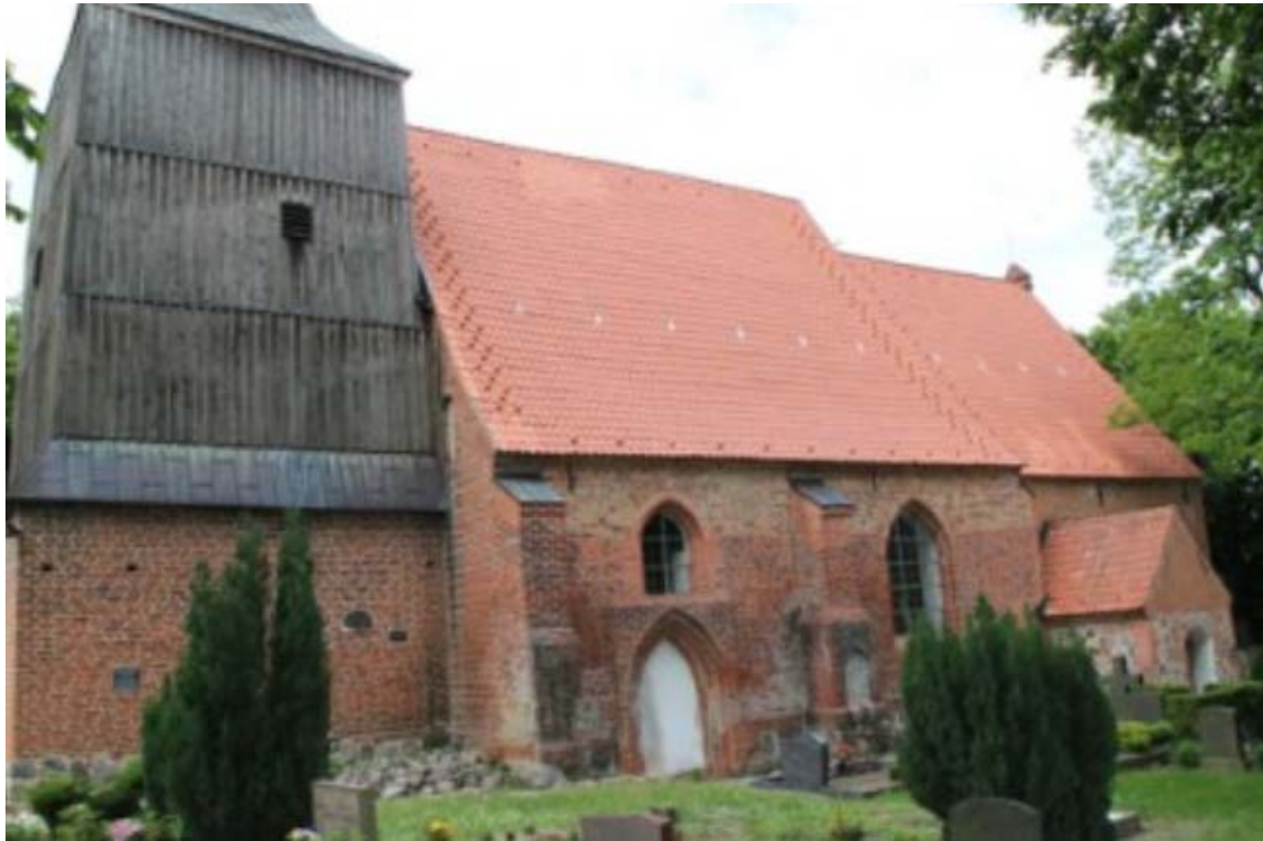
Abbildung 51: Dorfkirche Hohendorf, Quelle: https://www.dorfkirchen-in-mv.de/content/Version_1/detail_gesamt.php?Reg_Nr=289&bild=12030&wid=3695 , Abruf 23.06.2020
