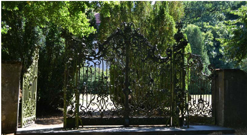
Abbildung 17: Denkmalgeschützte Toranlage, eigenes Foto vom 05.07.2018
