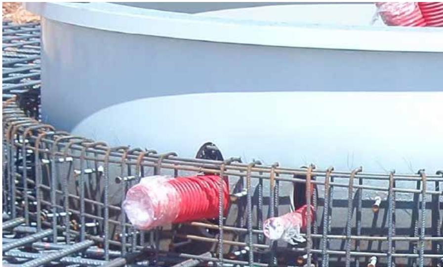
Abbildung 12. Fundamentring: Foto: Durchführung der Radialleiter und Windfarmenschutz
