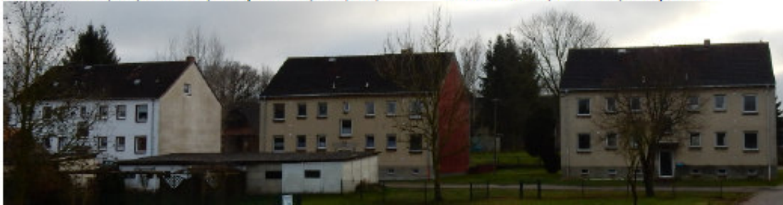
Bild 54: IO 69-71, Grieben, Hauptstr. 10, 9, 8 (vrnl)
