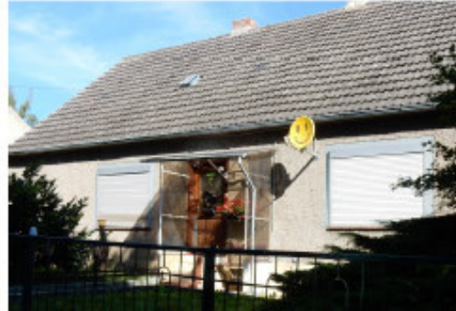
Bild 56: IO 74, Grieben, Hauptstr. 5
