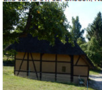
Bild 64: IO 84, Grieben, Nebenstr. 4
