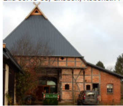
Bild 68: IO 88, Grieben, Nebenstr. 9
