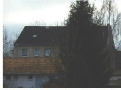
Bild 53: IO 72, Grieben, Hauptstr. 7
