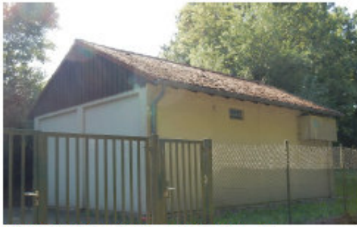
Bild 50: IO 65, Grieben, Hauptstr. 14
