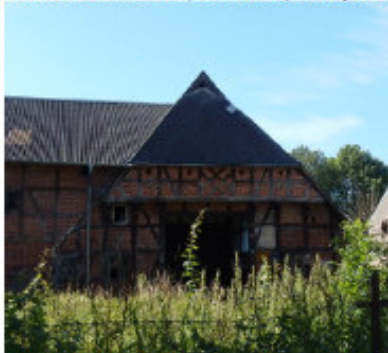
Bild 55: IO 73, Grieben, Hauptstr. 6
