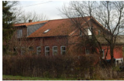
Bild 60: IO 79, Grieben, Hauptstr. 1
