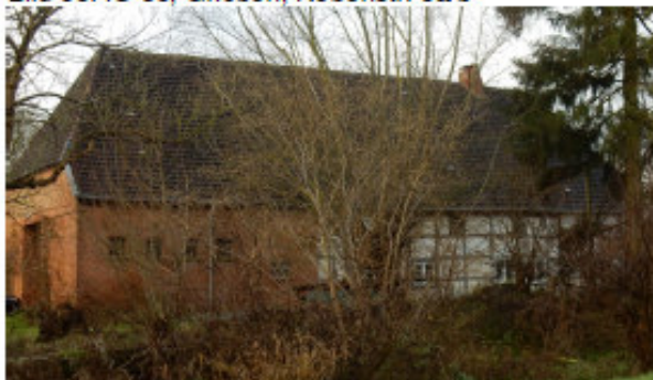
Bild 67: IO 87, Grieben, Nebenstr. 8
