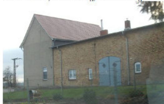
Bild 47: IO 61, Grieben, Hauptstr. 18
