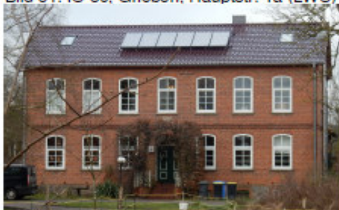
Bild 63: IO 83, Grieben, Nebenstr. 3
