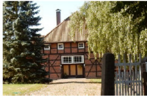
Bild 51: IO 66, Grieben, Hauptstr. 13
