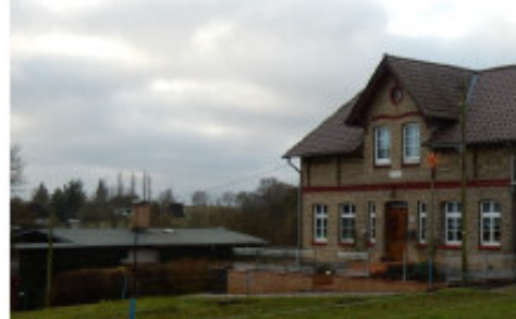
Bild 62: IO 81, 82, Grieben, Nebenstr. 1, 2 (vlr)
