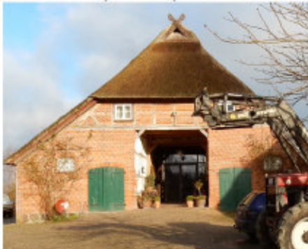
Bild 73: IO 93, Grieben, Nebenstr. 13
