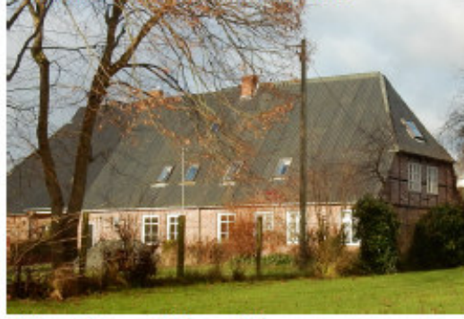
Bild 72: IO 92, Grieben, Nebenstr. 12
