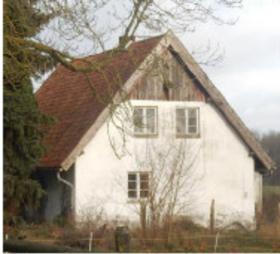
Bild 71: IO 91, Grieben, Nebenstr. 11
