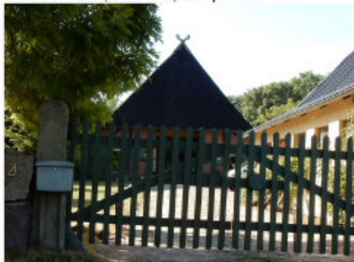
Bild 57: IO 75, Grieben, Hauptstr. 4
