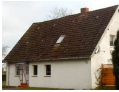
Bild 70: IO 90, Grieben, Nebenstr. 10
