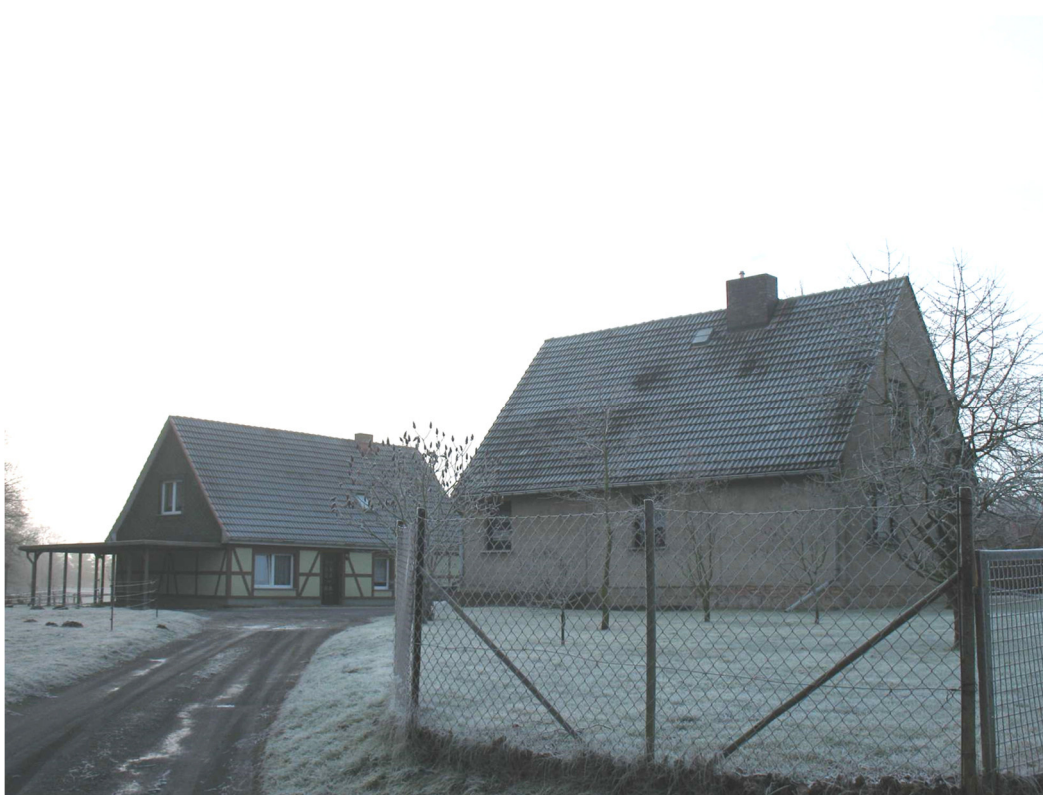
IP 02 Dambeck, Chausseestr. 20, Hinterhaus
